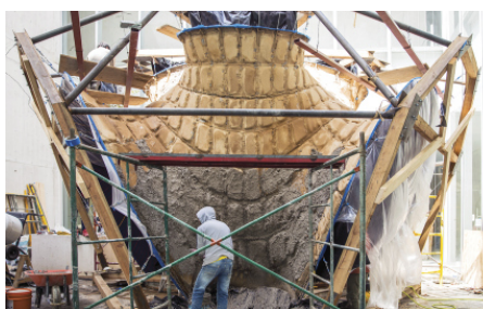
Figuras 3.32, 3.33, 3.34 y 3.35. Proceso constructivo del KnitCandela: Impresión 3D del tejido, tensado con cables y vertido del hormigón.
