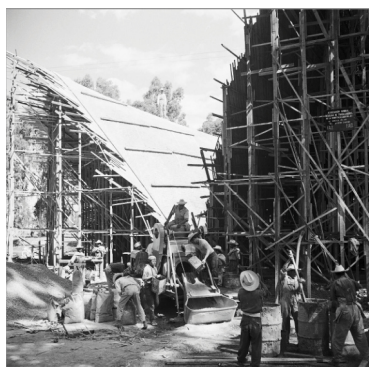
Figuras 2.10 y 2.11. Cimbra de madera empleada en el proceso constructivo del Restaurante de los Manantiales
