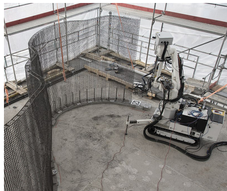
Figura 3.24. (izq) Robot ensamblando la malla de acero.
