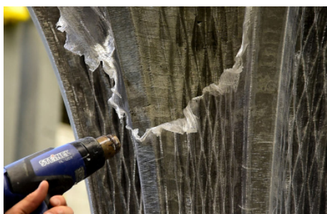
Figura 0.9. (superior dcha). Impresión del encofrado de hormigón con una impresora 3D.
