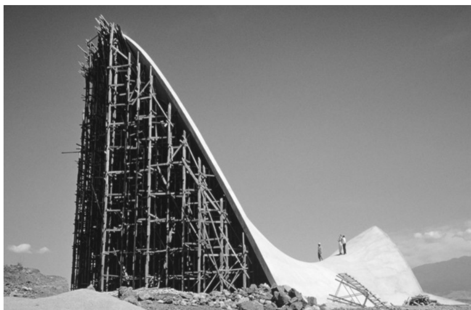
Figura 2.3. Proceso constructivo de una de las cáscaras de Félix Candela
