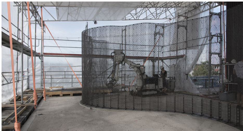
Figura 0.6. Proceso de instalacion y montaje de la malla de acero por el robot.
