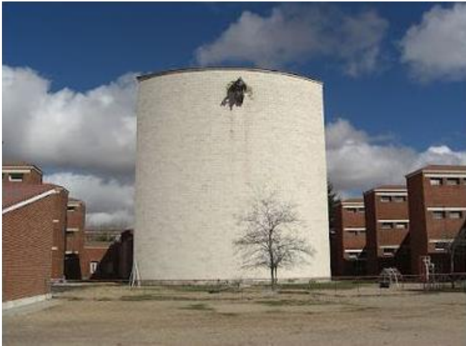
I. 31 Exterior iglesia Arcas Reales, Valladolid.
