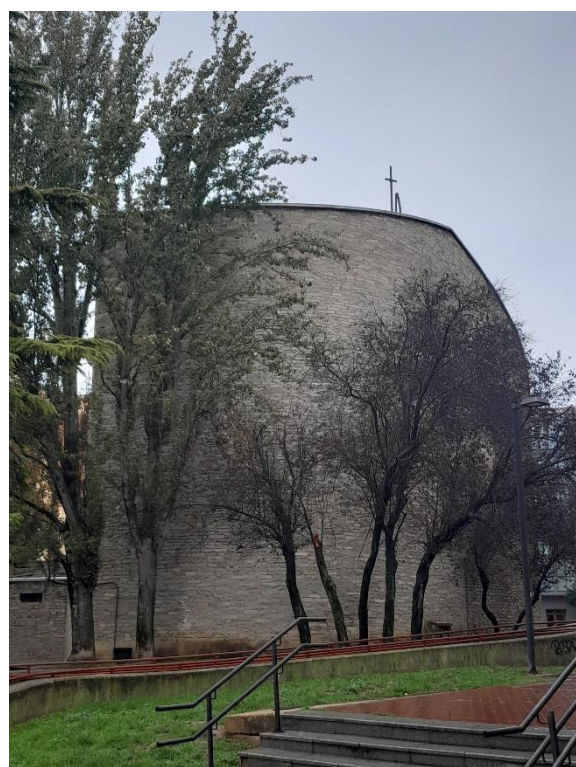
I. 55 Fotografía exterior de la iglesia por el muro dinámico.
