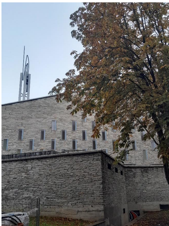
I. 54 Fotografía exterior de la iglesia por el muro estático.
