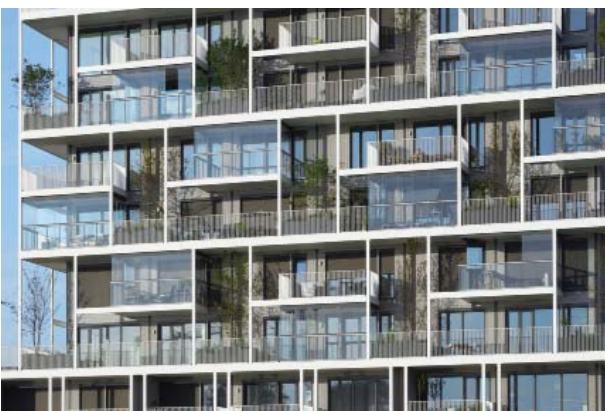
2.34. Vista exterior. Combinación de dobles alturas en terrazas
