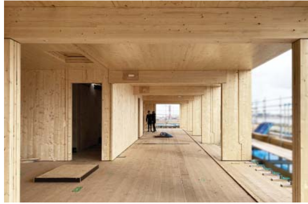
2.33. Vista interior estructura de madera
