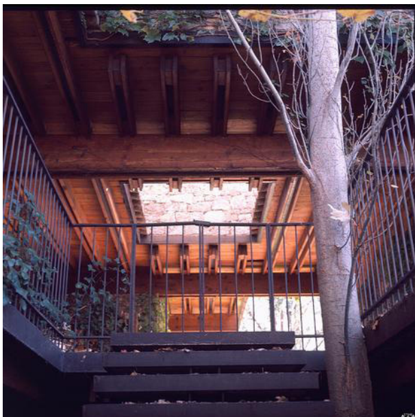
Figura 1.59. Fotografía de acceso secundario donde se observa la estructura de forjado de madera.
