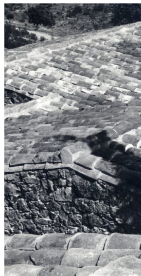
Figura 1.41. Fotografía zoom de la cubierta con los testeros ejecutados en piedra.
