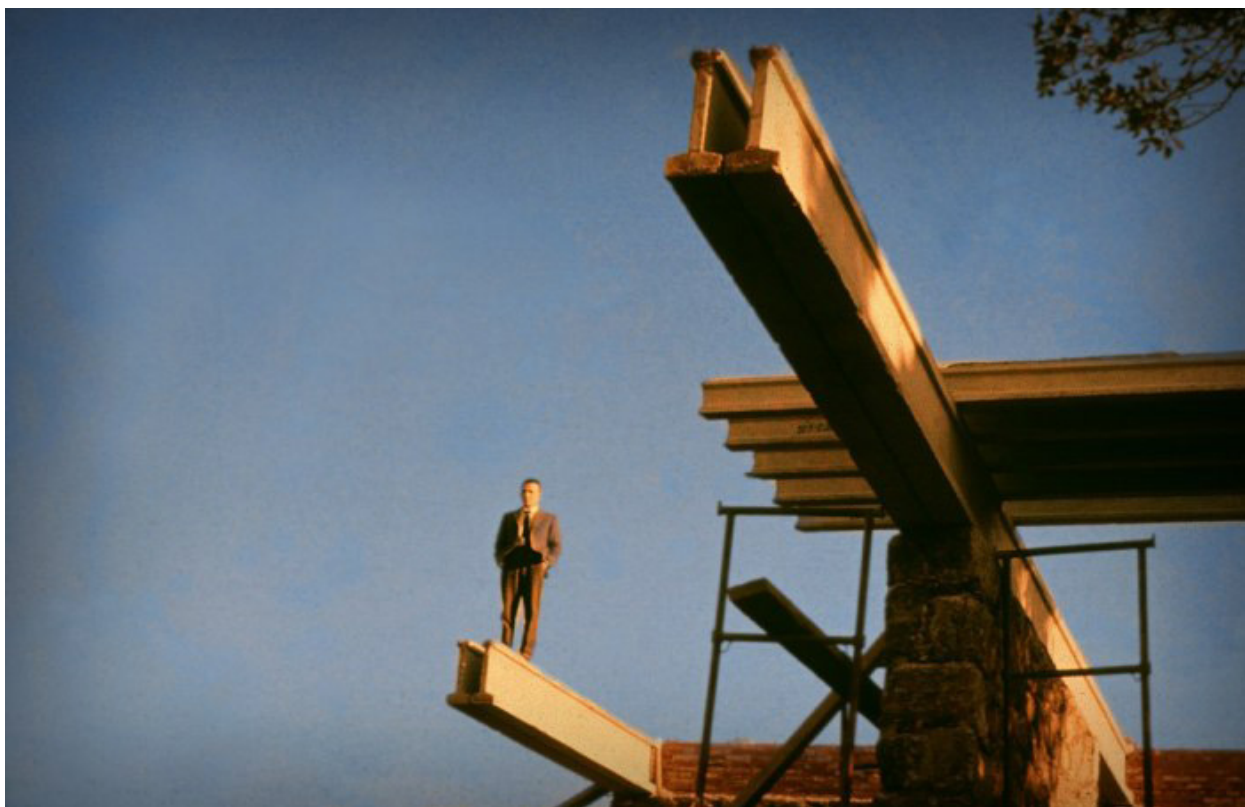
Figura 1.37. Fotografía de sistema de vigas en voladizo con remate de muros de piedra en fábrica de ladrillo.
