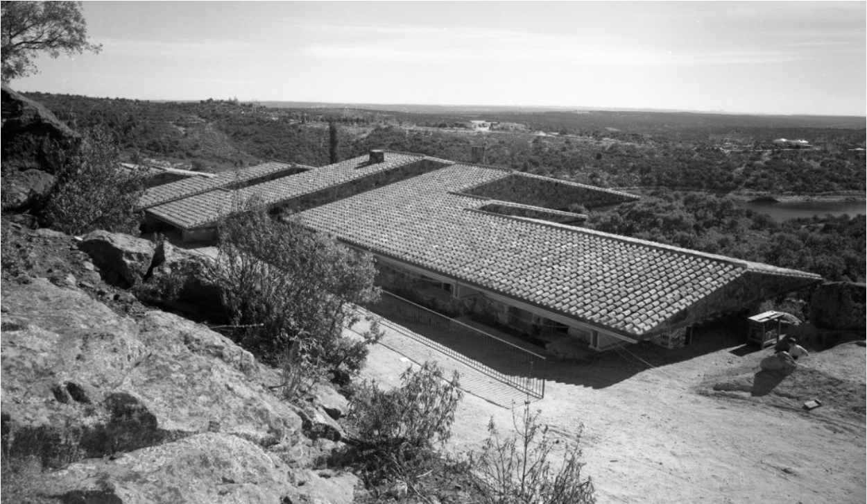
Figura 1.32. Fotografía del acceso a la vivienda por la rampa tangente a la fachada Norte semienterrada.
