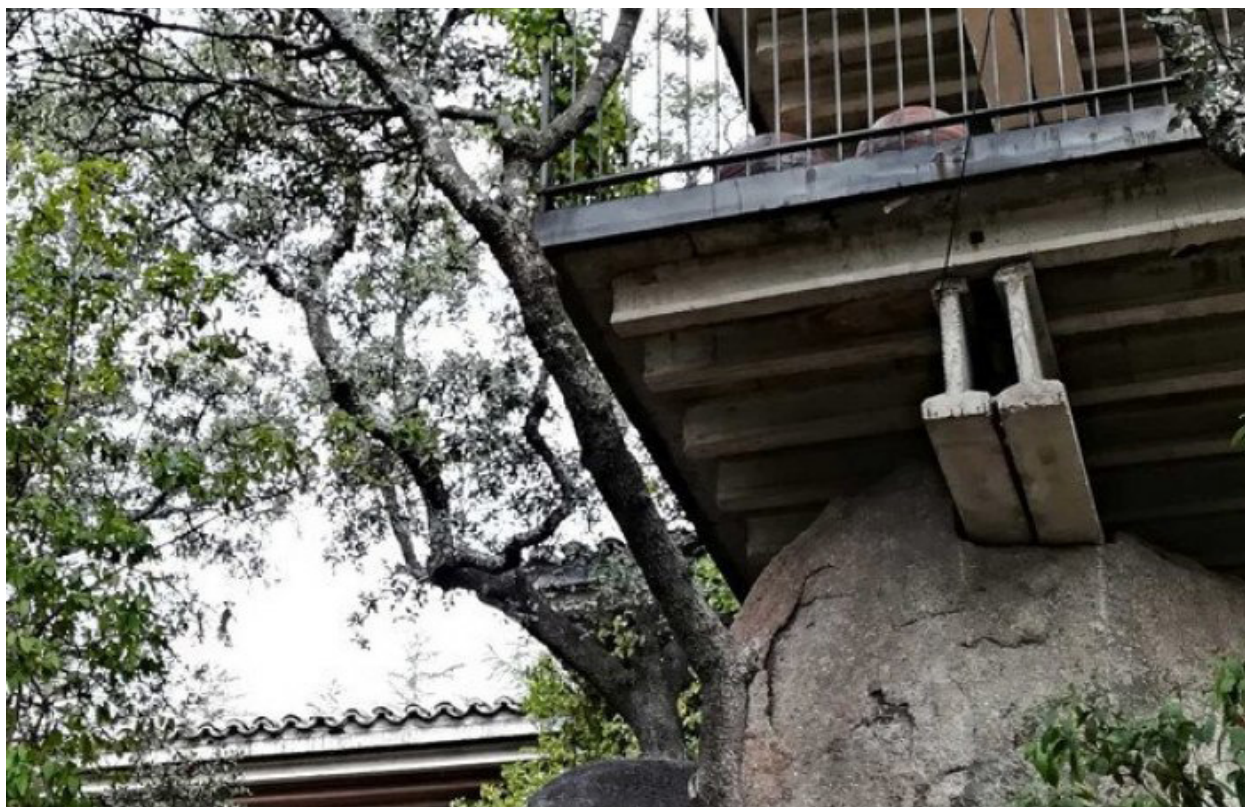
Figura 1.35. Fotografía de la estructura de vigas prefabricadas sobre una roca, con la intención de respetar hasta el extremo lo preexistente.
