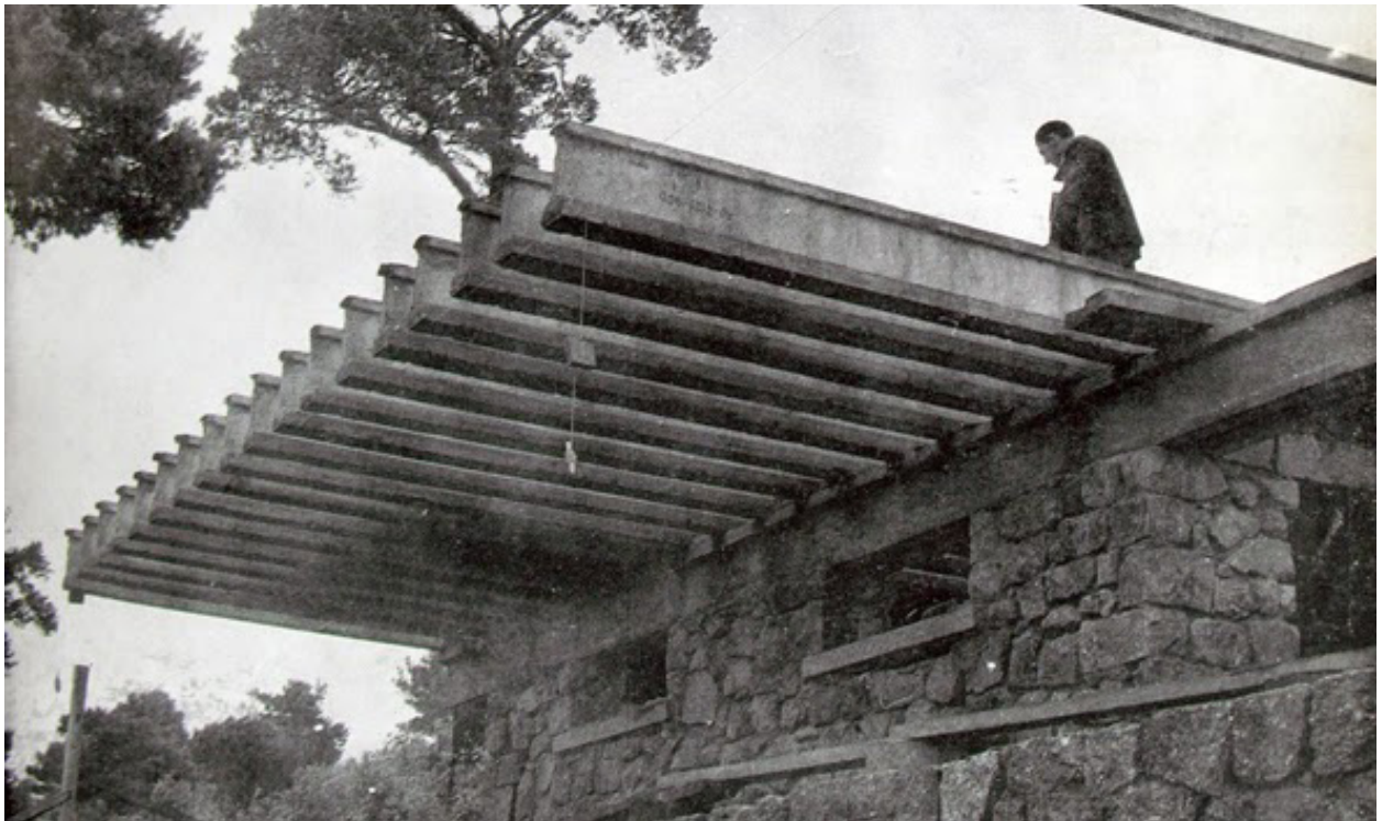
Figura 1.15 Fotografía del proceso constructivo de la casa César Manrique. Colocación de vigas en voladizo.
