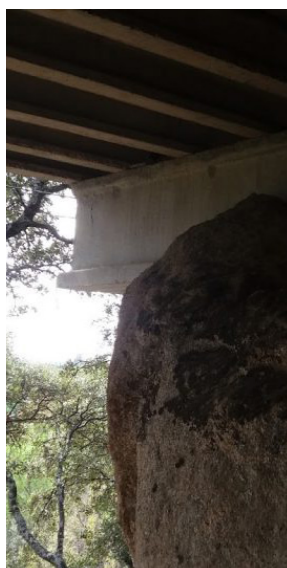
Figura 1.36. Fotografía del mismo encuentro viga-roca desde otra perspectiva.
