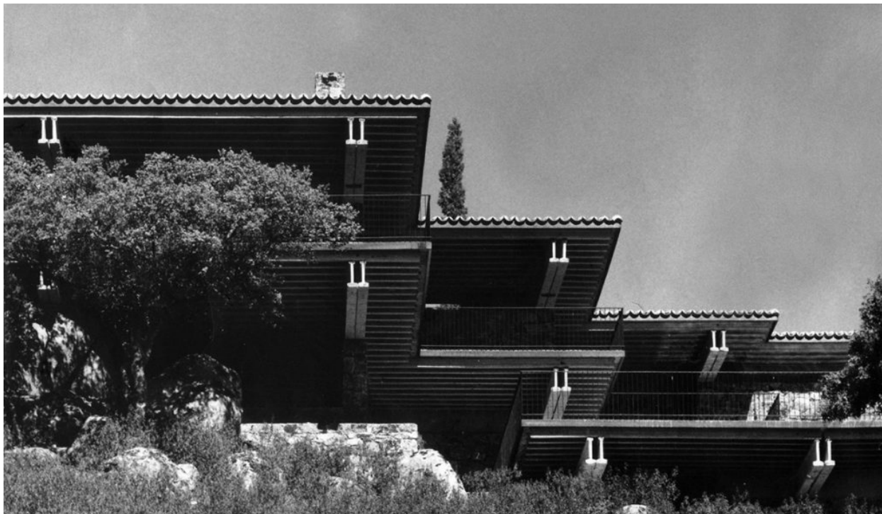
Figura 1.31. Imagen exterior de las fachadas Sur, observando la estructura de grandes vigas en voladizo.
