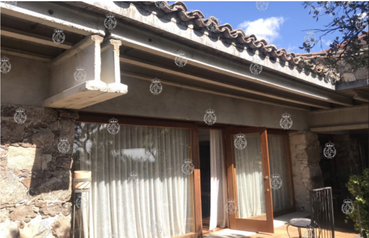
Figura 1.38. Fotografía de recurso viga-dintel cerramiento de fachada sobre hueco de ventanas y puertas
