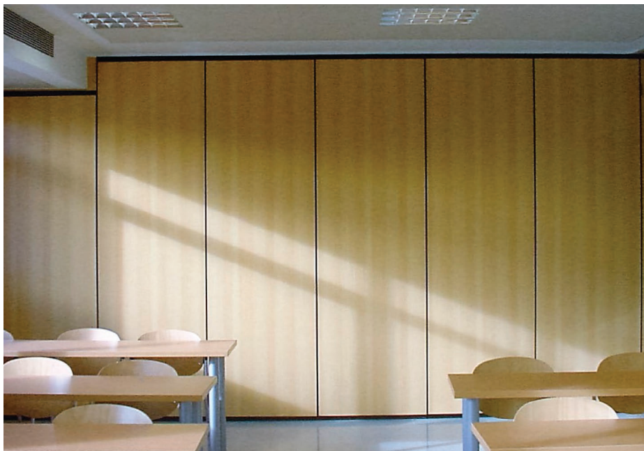
4.24. Ejemplo de acabado de unos tabiques móviles en un aula.
