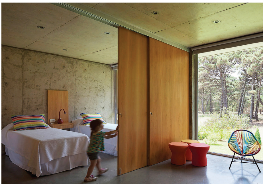
4.25. Ejemplo del funcionamiento de un tabique móvil de madera en una vivienda.
