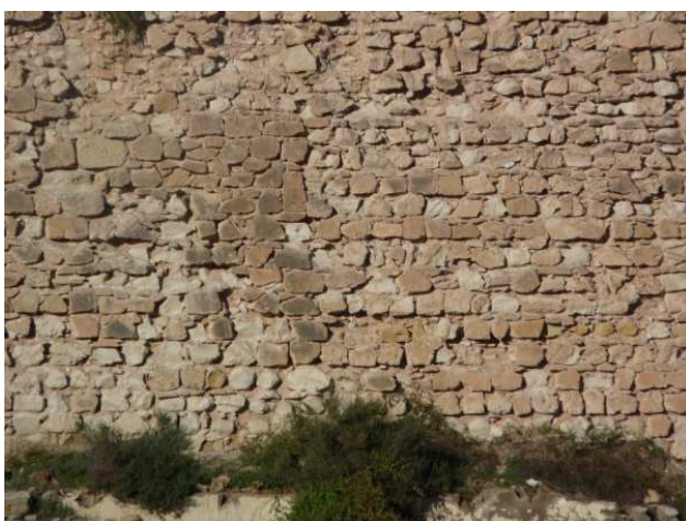
Figura 13.4. Baluarte de la Campana (a). Escarpe del lienzo S2-L3. Mampostería concertada de piedra caliza, organizada en hiladas horizontales regulares, la piedra es de figura cuadrada y de unos 22x22 cm y reforzada
