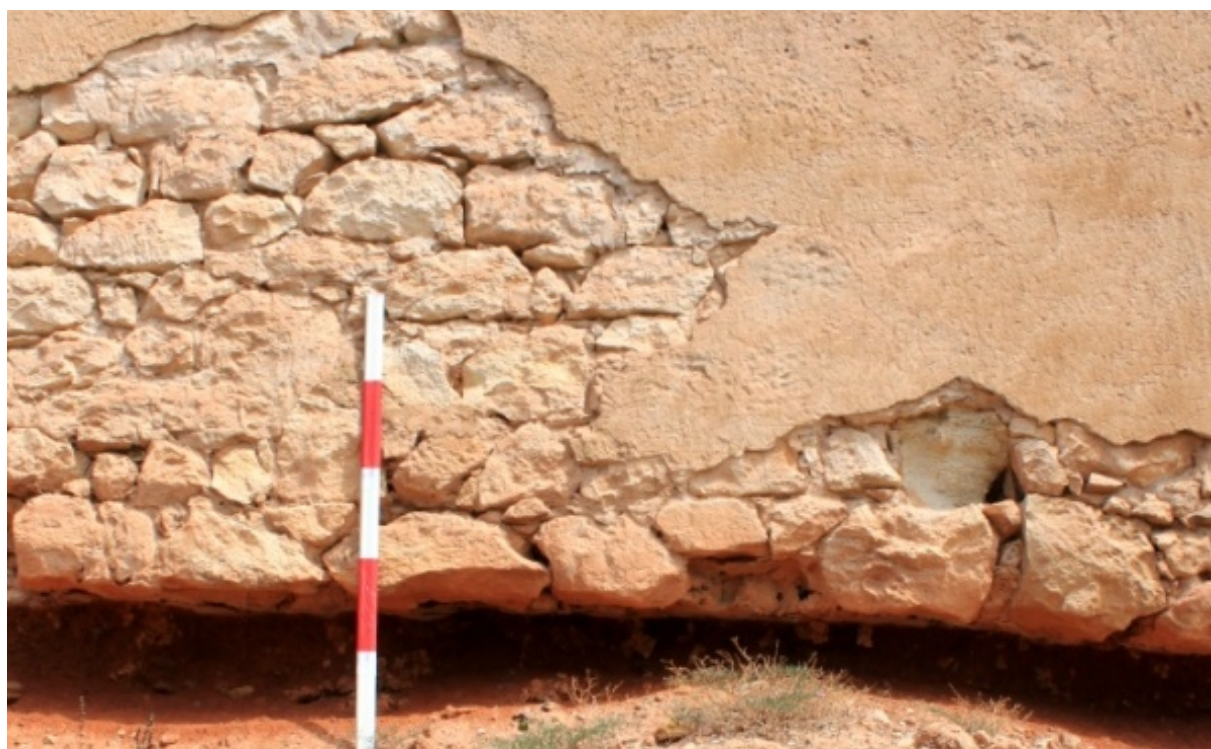
Figura 10.26. Detalle del revestimiento.
