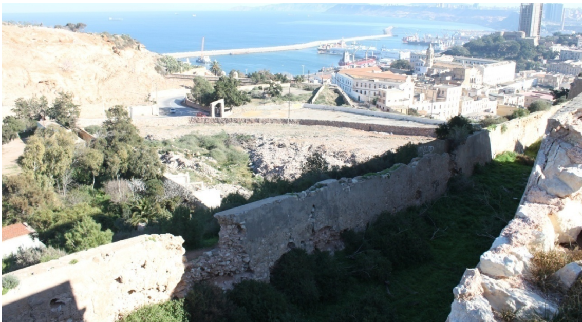
Figura 11.27. Vista de la contra escarpa.
