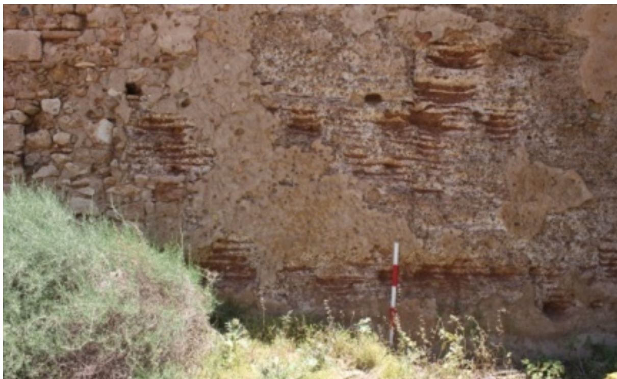
Figura 11.30. Paramento de la torre
