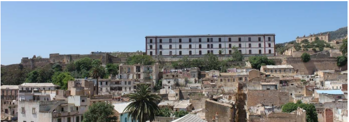
Figura 8.12. Vista general del sector S4.
