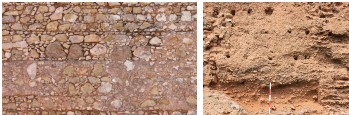
Figura 11.19. Detalle de la fábrica del baluarte (a). Detalle de la tapiá del terraplén el baluarte (b)
