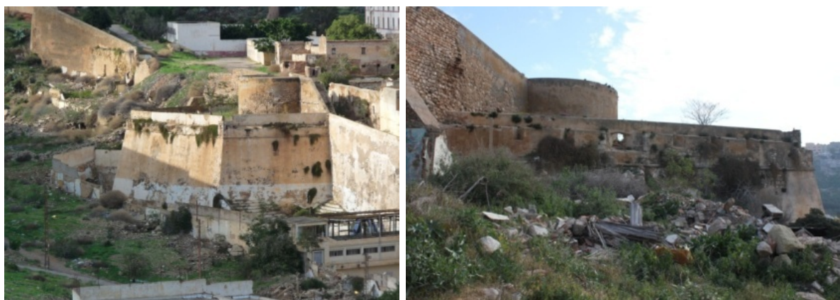
Figura 10.12. Vistas del baluarte de Santiago
