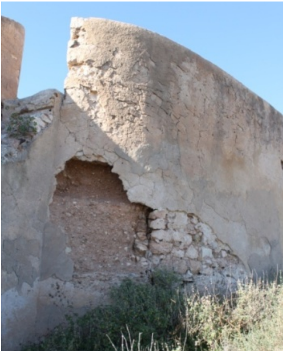
Figura 11.10. Parte donde se une el cubo con la muralla.
