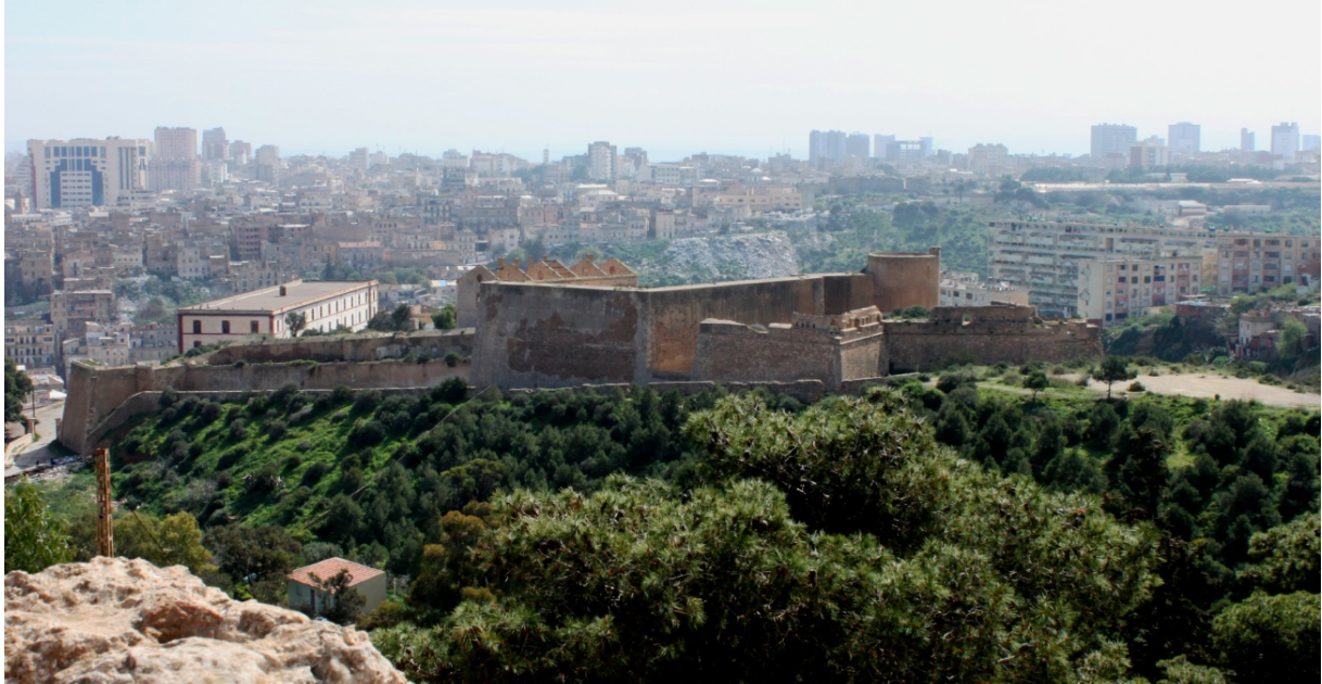
Figura 11.2. Vista general del frente de la Campana
