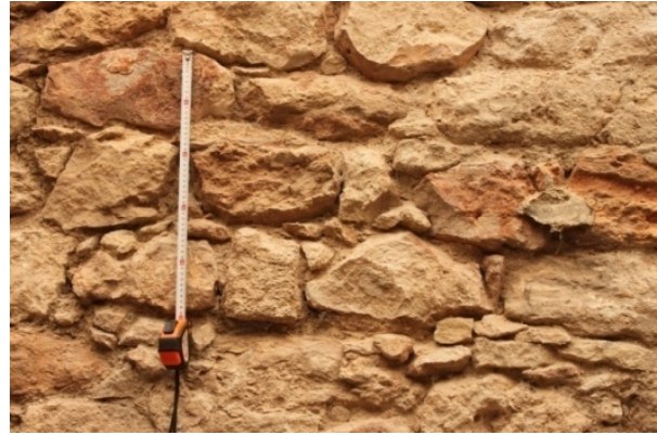
Figura 9.15. Escudo situado en el trasdós de la puerta de España (a). Detalle de la fábrica de mampostería de dicho muro (b).
