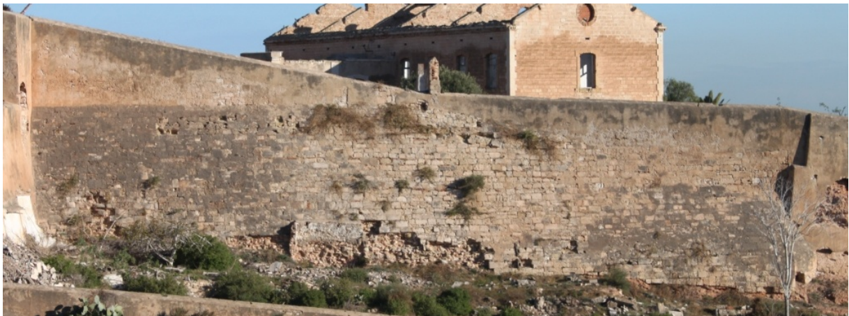
Figura 10.28. Fotografía del tramo b del lienzo L13.
