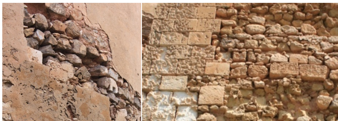
Figura 13.5. Lienzo S2-L2 fábrica de mampostería, predomina la mampostería concertada en hiladas regulares, con piedras de tamaño mediano dispuestas a tizón, fechada en 1744.
