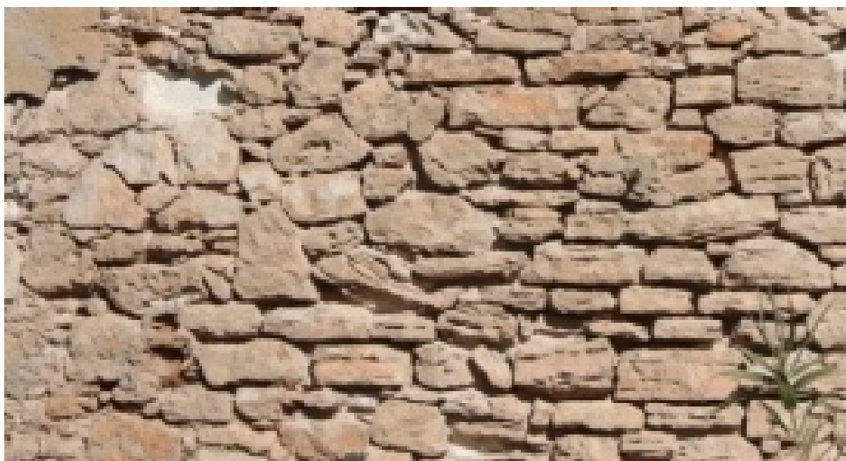
Figura 31.10. Detalle del aparejo del cubo artillero de Santiago.
