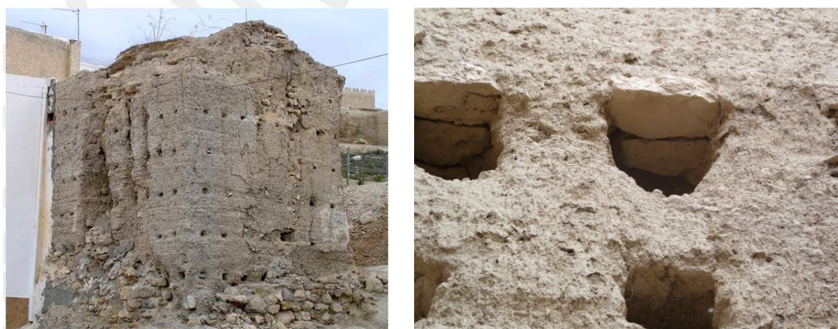
Figura 13.13. Torre de flanqueo del frente oeste de la medina de Almería (a) (Gurriarán, 2017: 323). Detalle del uso de cielo de piedra en fábrica de tapia del castillo de Palenzuela (b) (Foto cedida por Ignacio Gil Crespo)
