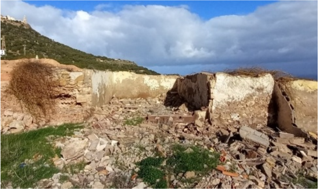
Figura 11.25. Interior de la torre.
