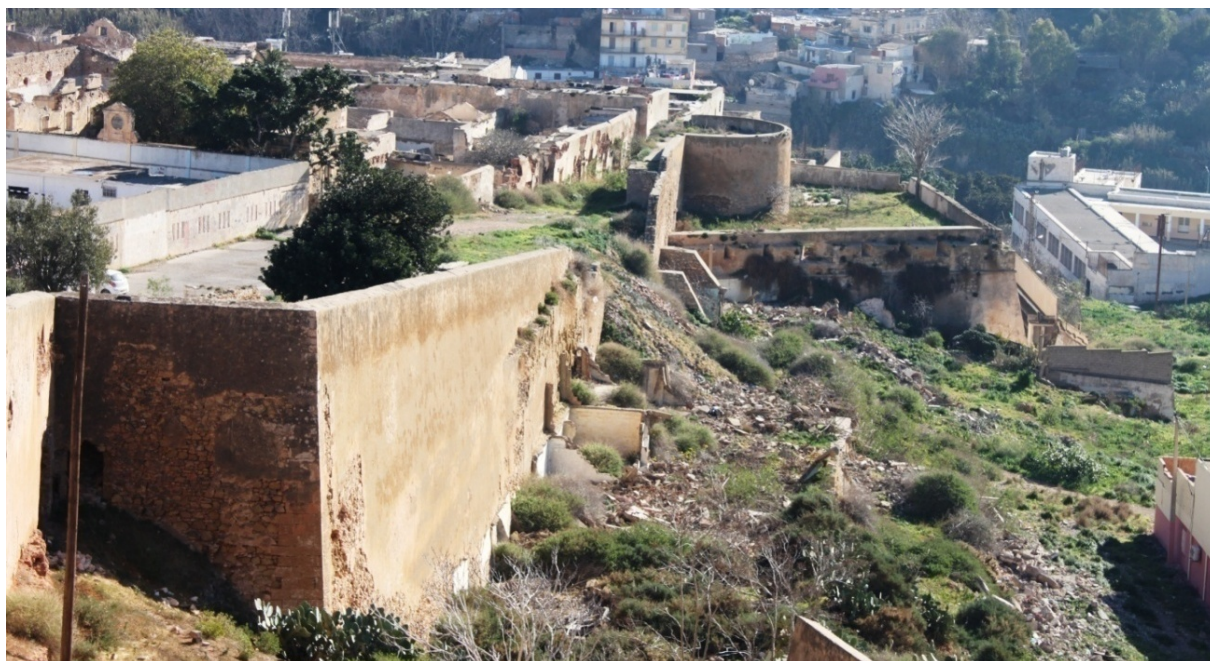
Figura 10.20. Vista lateral del baluarte de los Leones.
