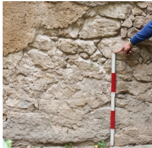
Figura 9.9. Detalle de la fábrica de tapia (a). Detalle del revestimiento de mampostería (b)
