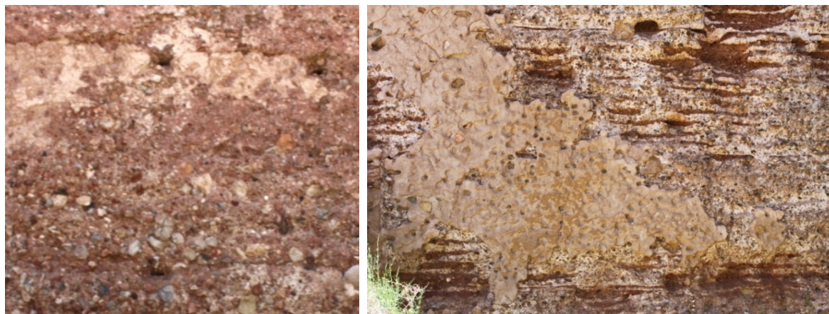
Figura 13.12. Tapia tipo T2 atribuida a la fase constructiva Meriní. El tipo T2 también lo localizamos en el lienzo S2-L3 y presenta similitudes con el terraplén de la tenaza que también coincide con la ubicación del castillo medieval. (izquierda).
