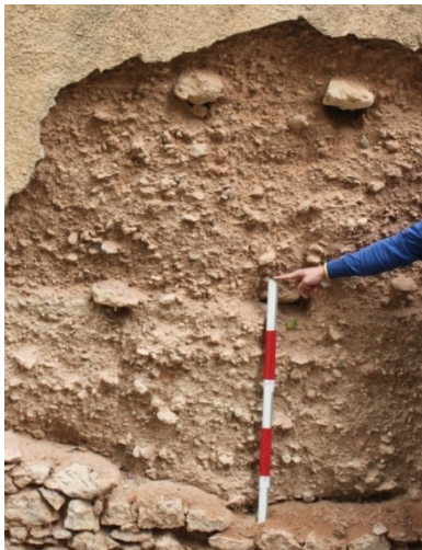
Figura 9.9. Detalle de la fábrica de tapia (a). Detalle del revestimiento de mampostería (b)
