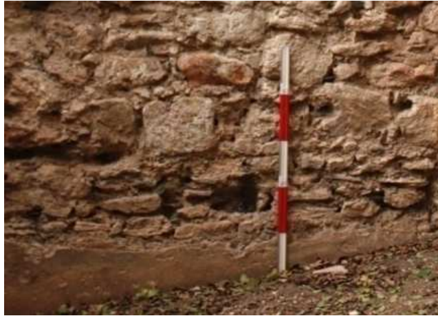
Figura 13.3. Mampostería de reparación MO2 en el baluarte Santa Isabel S1-E3 y en el lienzo S1-L3.
