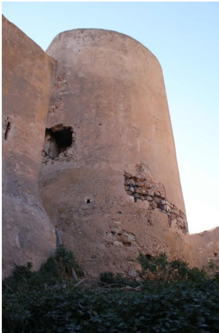
Figura 11.6. Vista del cubo artillero de la campana desde el foso.
