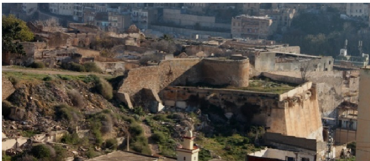
Figura 10.16. Vista del tramo colapsado
