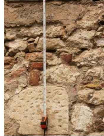
Figura 13.3. Mampostería de reparación MO2 en el baluarte Santa Isabel S1-E3 y en el lienzo S1-L3.
