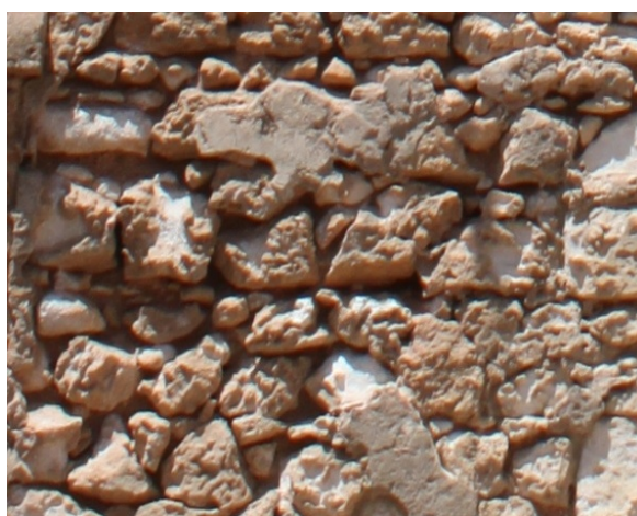
Figura 9.17. Detalle de la fábrica de mampostería en la parte baja de la fachada.
