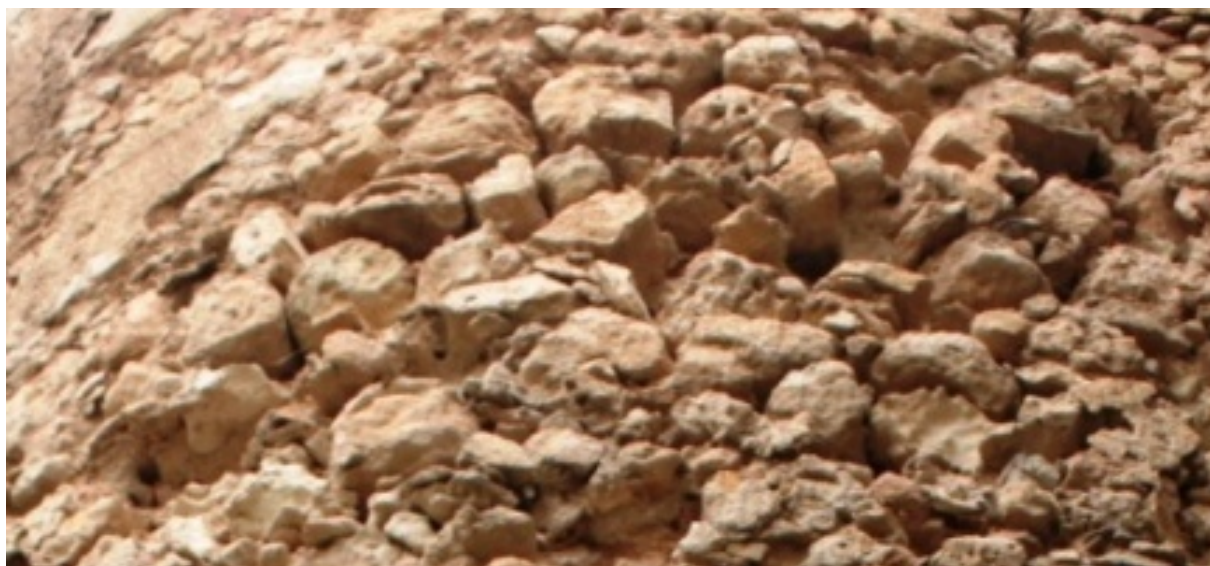
Figura 13.9. Mampostería concertada en hiladas horizontales correspondiente a la torre del sector S1. La tendencia es la de querer atribuirlo al medievo, aunque por ser un tipo de fábrica muy utilizado en diversas épocas resulta difícil atribuirlo con certeza a una dinastía en particular.
