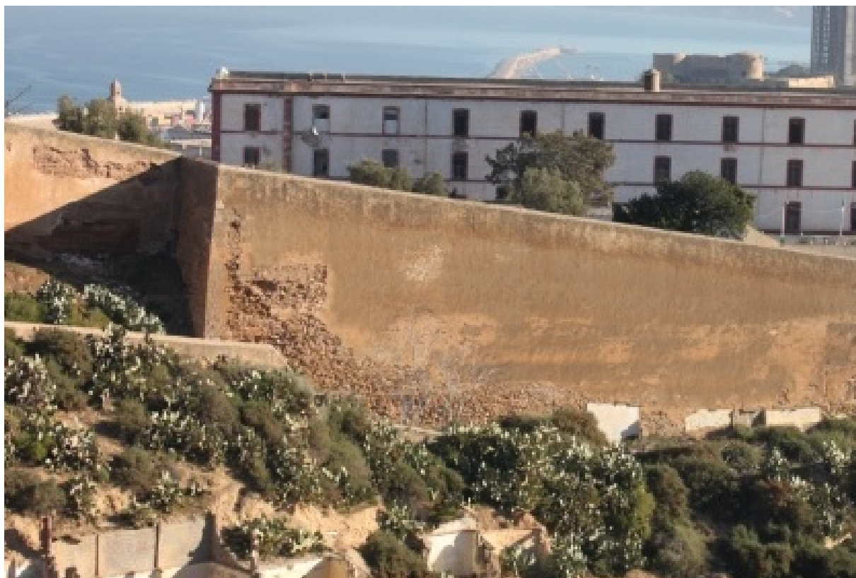
Figura 10.19. Vista frontal del baluarte de los Leones (en el fondo de la foto se ven los cubos artilleros del fuerte del Rosalcázar).
