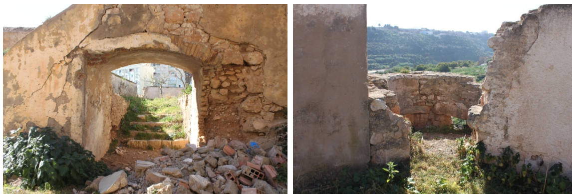
Figura 10.13. Acceso a la batería del baluarte. Figura 88. Los restos de la garita
