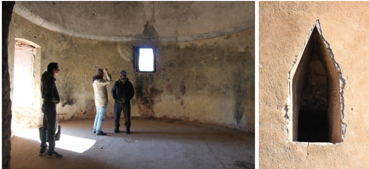
a b Figura 11.7. Interior de la bóveda (a). Hueco de forma singular (b).
