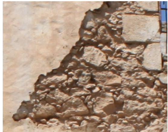
Figura 9.18. Escudo de la fachada principal (a). Detalle de mampostería ordinaria de la primera planta.
