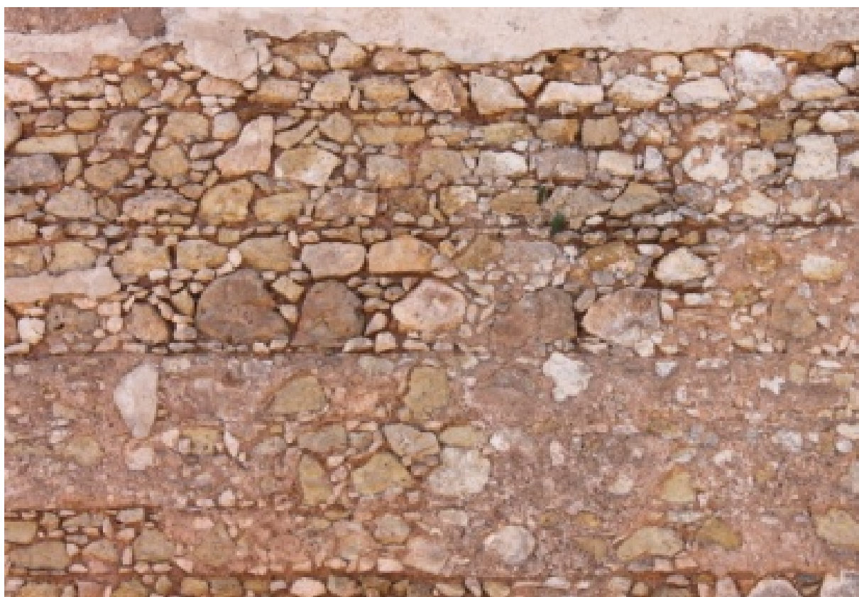
Figura 13.8. Las esquinas están reforzadas con sillares, estuvo revocado por completo, sin embargo el revoco se ha desconchado en gran proporción, se utilizan diferentes tipos y tamaños de piedra, además del empleo de ripios o mampuestos de tamaño reducido para uniformizar o nivelar las determinadas hiladas, existe una intención de regularidad, aunque hay hiladas más altas que otras, miden entre 25 cm y 40cm de alto, aproximadamente, el grosor de la junta es variable, entre 1 cm y 3 cm dependiendo del tamaño y la forma de las piezas utilizadas. Se encuentra en el baluarte de la Palma, así como en la tenaza, fechada en el siglo XVIII.
