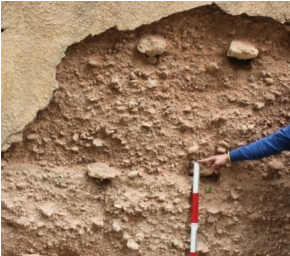
Figura 13.11. Tapia tipo T1, localizada en el sector S1, fechada en el siglo XVI.
