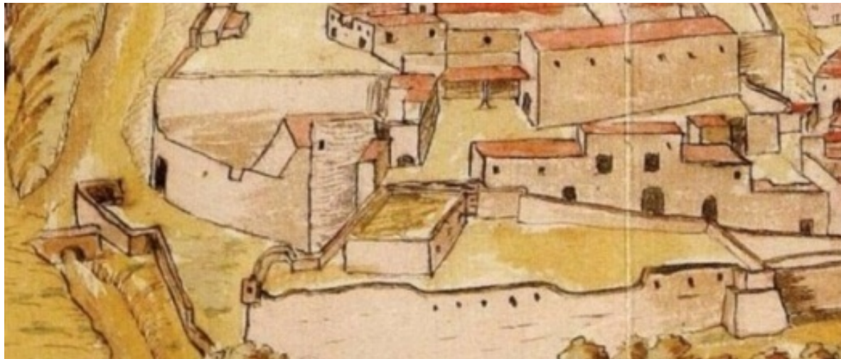
Figura 9.2. La puerta de Tremecén en el periodo medieval, situada en el muro que hace curva, a la izquierda del dibujo 42 (Leonardo Turriano, 1589).
