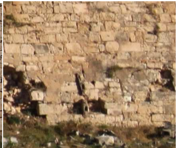
Figura 13.4. Baluarte de la Campana (a). Escarpe del lienzo S2-L3. Mampostería concertada de piedra caliza, organizada en hiladas horizontales regulares, la piedra es de figura cuadrada y de unos 22x22 cm y reforzada
