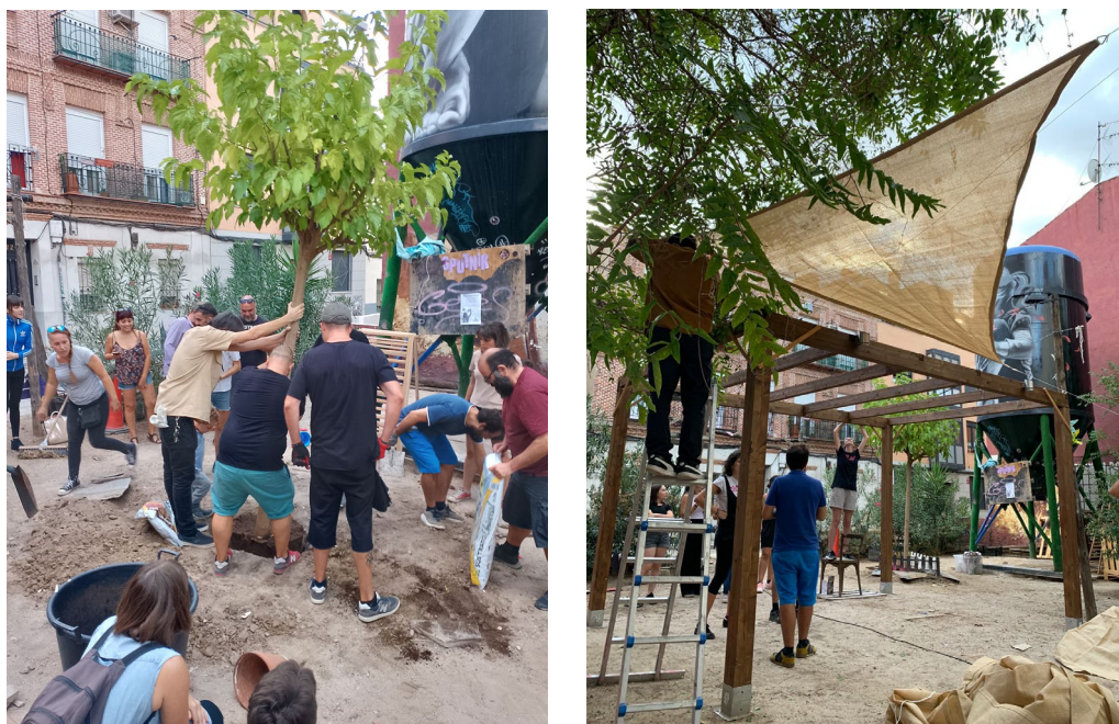
Figura 4. Imágenes de la intervención exterior en el espacio vecinal Sputnik.
