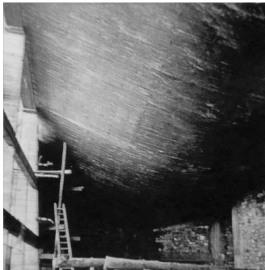
Figura 54. Le Corbusier. (1953-1955). Espacio interior en construcción de la capilla de Ronchamp; donde la bóveda curvada se erige en protagonista del espacio. (Foto de Hervé, Lucien. 1955). Sbriglio, Jacques. Le Corbusier & Lucien Hervé, The Architect & the Photographer, A Dialogue . United Kingdom: Thames & Hudson, 2011. p. 91, E.I. 126. Nº. 58.
