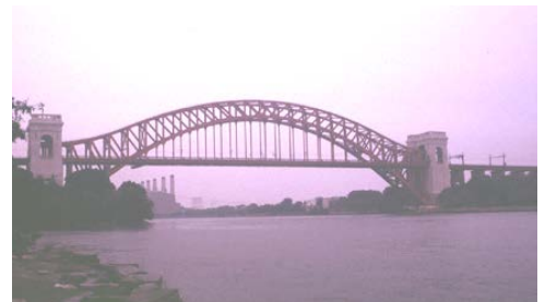
Fig. 47.- Puente Hell Gate.
