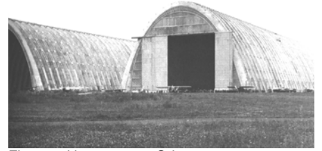
Fig. 75.- Hangares en Orly.
