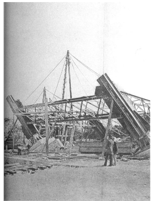
Fig. 13.- Torre Eiffel en construcción.
