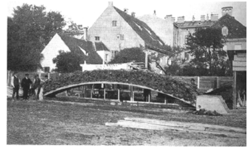
Fig. 52.- Ensayo de estructura de un puente según el sistema Monier, Viena, hacia 1887.
