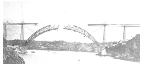
Fig. 42.- Viaducto de Porto.
