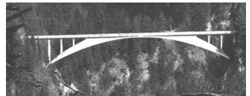
Fig. 55.- Puente de Salginatobel.
