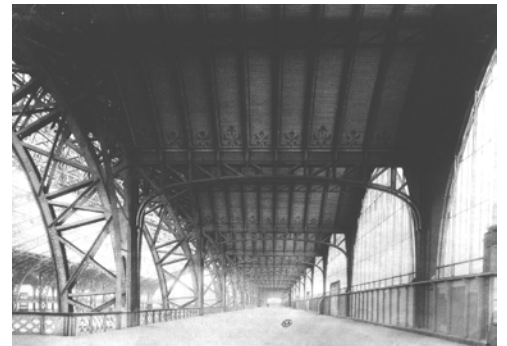
Fig. 66.- Galería de máquinas.
