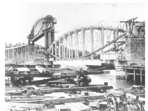
Fig. 37.- Puente de Saltash. Detalle de la construcción.
