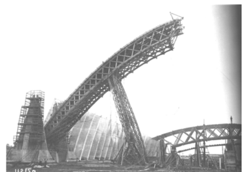
Fig. 77.- Hangares en Orly.
