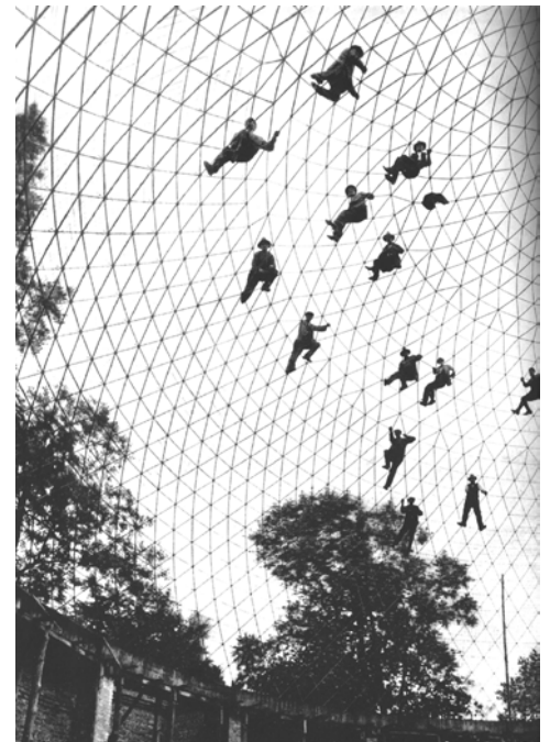
Fig. 78.- Malla de la cúpula del planetario Zeiss durante su construcción.
