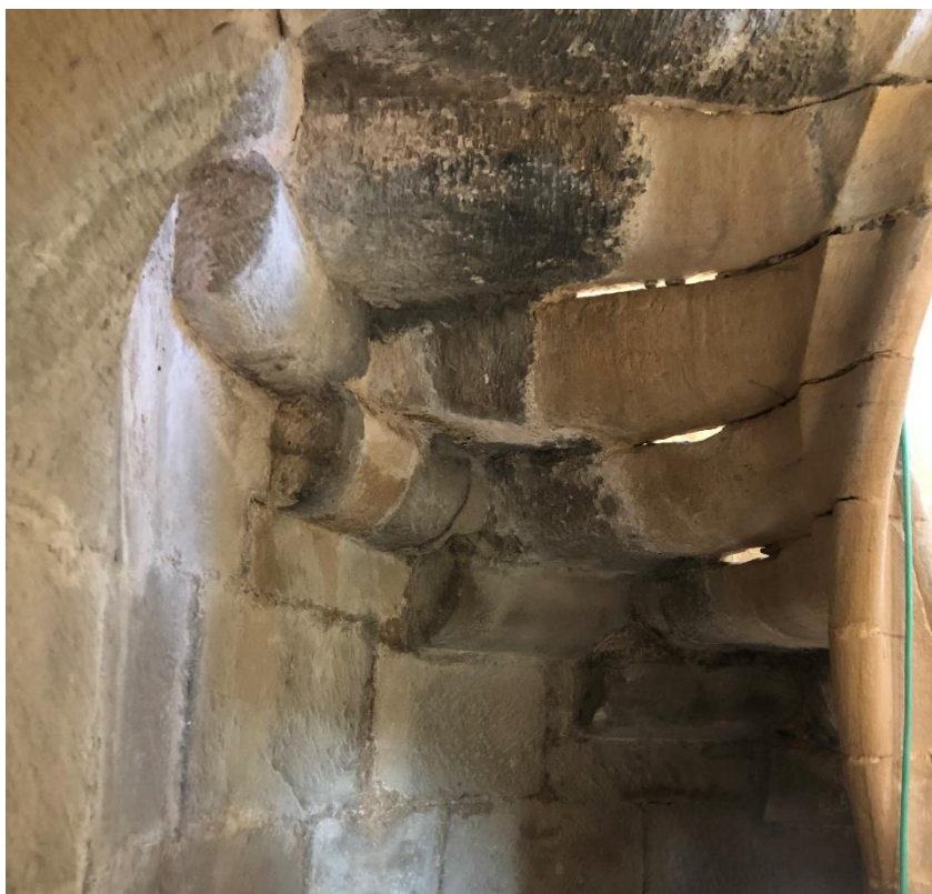
Fig. 3.2 - Escalera de caracol de ojo abierto, imagen donde se puede ver el estrechamiento del cilindro y la separación entre peldaños que evidencian el funcionamiento estructural de la escalera a través del nervio. Elaboración propia.
