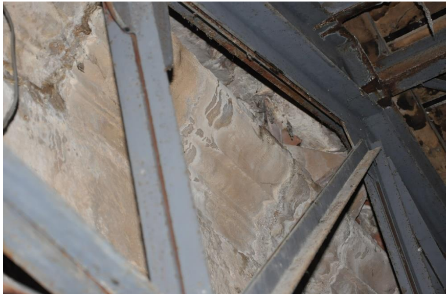
Fig. 3.20 – Interior del espacio de bóvedas de la iglesia. La cercha metálica de la cubierta deja entrever la cornisa de la torre que queda oculta bajo el tejado.
