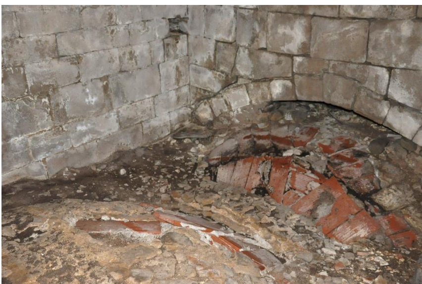
Fig. 3.19 - Interior del espacio de descarga tras atravesar los arcos. Imagen donde se pueden ver las capas de rasilla sobre las bóvedas originales de crucería de la sala intermedia.
