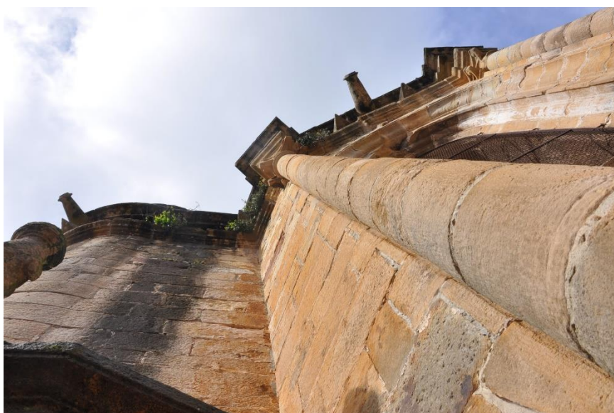
Fig. 3.32 - Imagen de detalle de la intersección entre las pilastras y el cilindro de la escalera.
