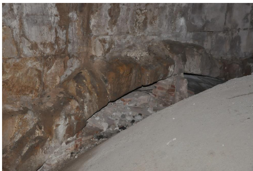
Fig. 3.23 - Detalle del arco de descarga posterior desde la sala de bóvedas. Elaboración propia.
