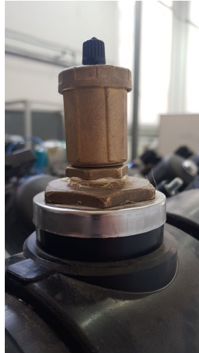
Figura 4.1: Imagen detalle de uno de los purgadores de las tuberías PT100. Fuente: E.P.
