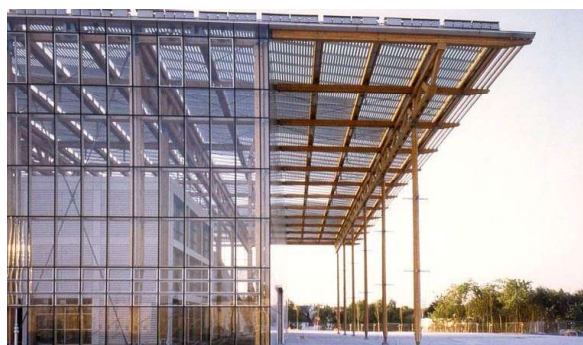
Figura 3.8. (izq.) Detalle de fotovoltaicas de la Academia Mont Cenis.
