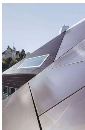
Figura 4.1. (izq.) Detalle de fachada BIPV. Wohnhaus Solaris, Huggenbergerfries Architekten.
