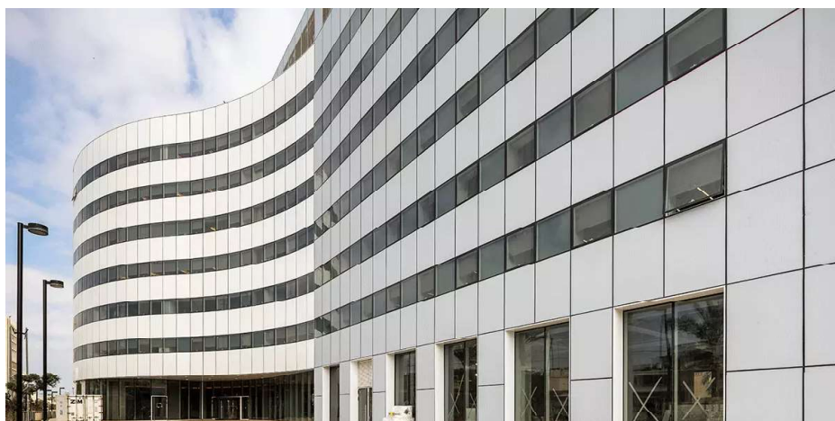
Figura 3.24. Edificio Beit Havered (Israel) con integración de fotovoltaicas en fachada con impresión cerámica blanca.
