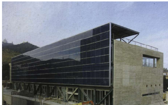
Figura 3.15. (izq.) Detalle de fotovoltaicas Parque de Innovación Tecnológica La Salle.
