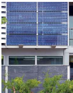
Figura 3.10. (izq.) Detalle de fotovoltaicas de la Fundación Metròpoli.
