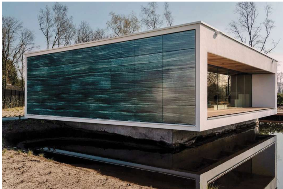
Figura 4.19. (encima) Detalle de serigrafía de vidrio fotovoltaico, Sauna House (HeliArtec).
