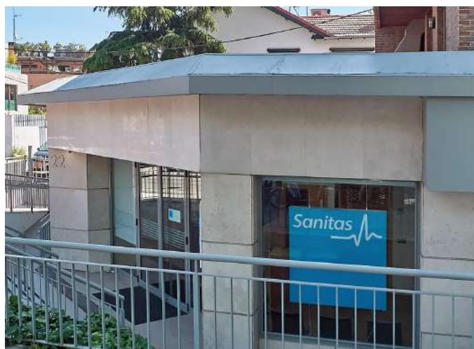
Imagen 17. Fotografía de la fachada principal Edificio General López Pozas 22 del Hospital Virgen del Mar
