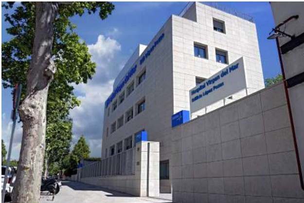
Imagen 14. Fotografía Edificio Honduras del Hospital Virgen del Mar
