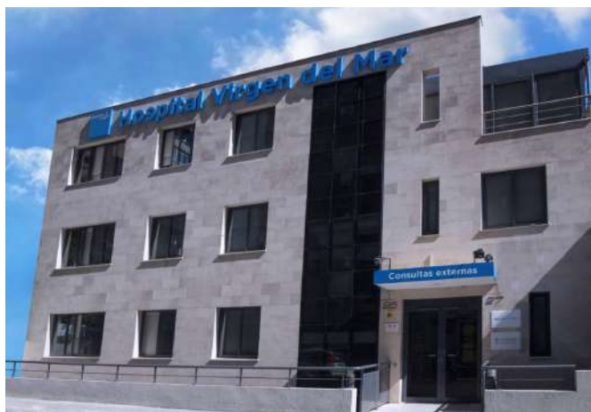
Imagen 15. Fotografía Edificio Nuestra Señora de Luján del Hospital Virgen del Mar
