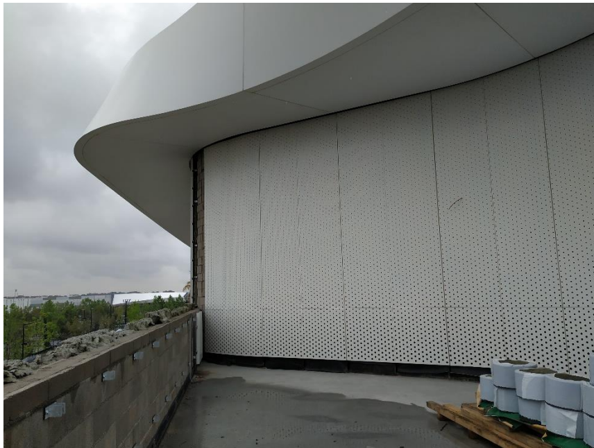
Figura 24: Fotografía Exterior de la Fachada en Contacto con el Exterior
