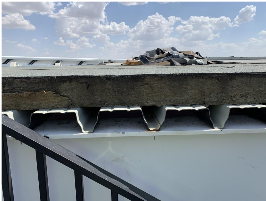
Figura 21: Fotografía del Estado Actual de la Cubierta
