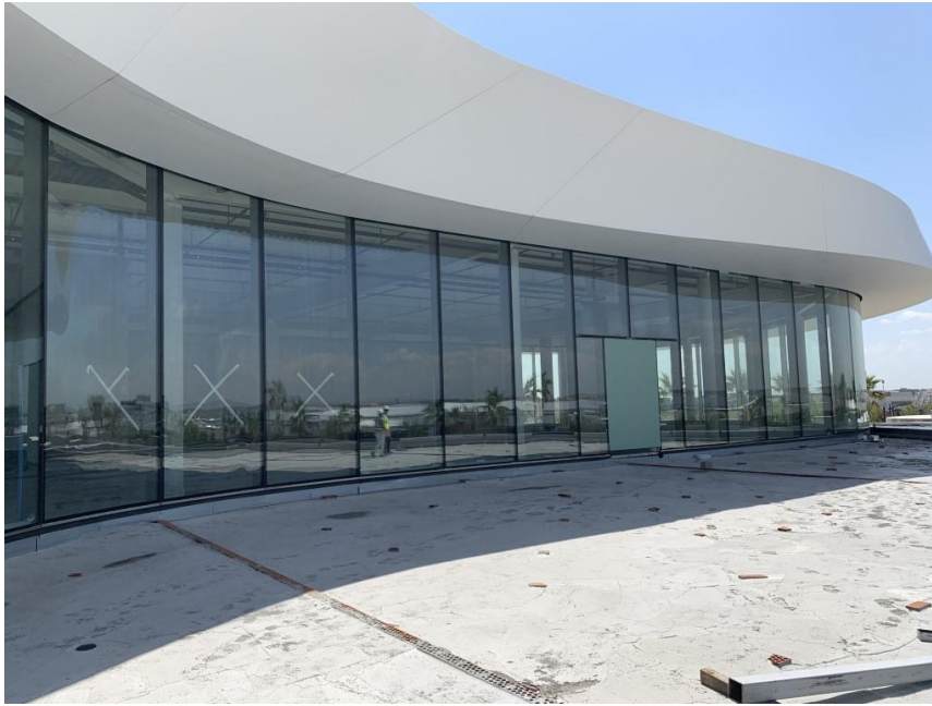
Figura 25: Fotografía del muro cortina
