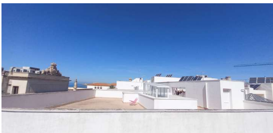
Figuras 1.18 Fotografía de la cubierta del nuevo edificio (módulo A). Abril 2023.
