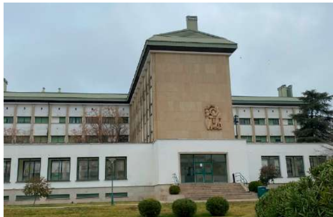
o.7 Exterior de los edificios con planta en forma de cruz.
