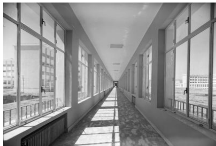
2.14 Tercer bloque de edificio
