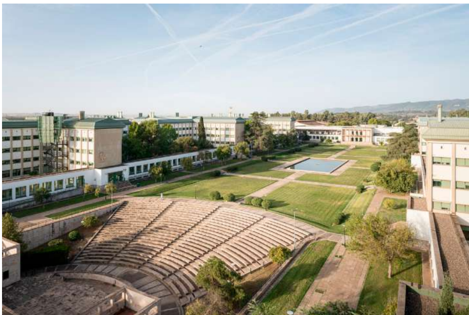
3.1 Exterior del conjunto actual
