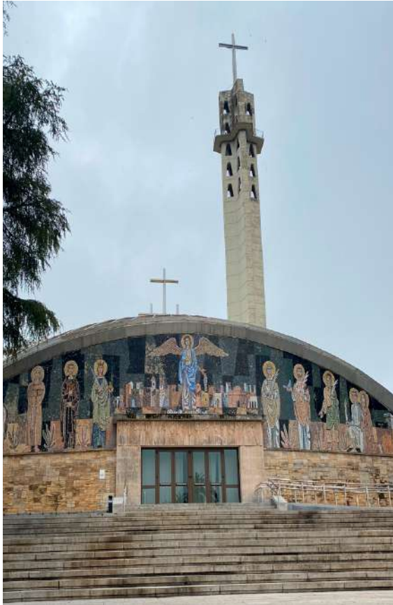
o.5. Estado actual de la Iglesia.
