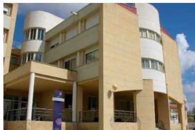
3.76 Edificio Ramón y Cajal.
