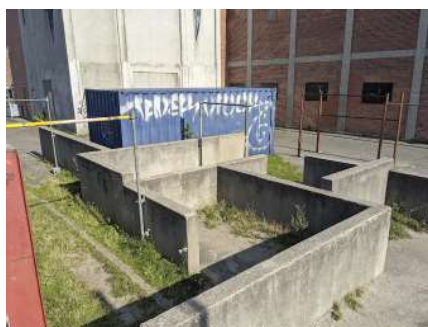
Figuras 3.2.1. y 3.2.2. Imágenes de un parque de parkour construido a partir de estructuras preexistentes en la ciudad de Odense, Dinamarca.
