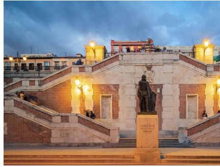
Figura 2.1.3. Fotografía de la situación actual de la escalera.
