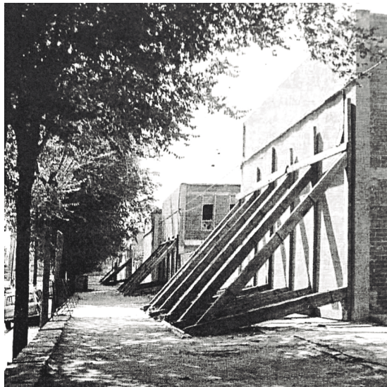
Recalces de los bloques
