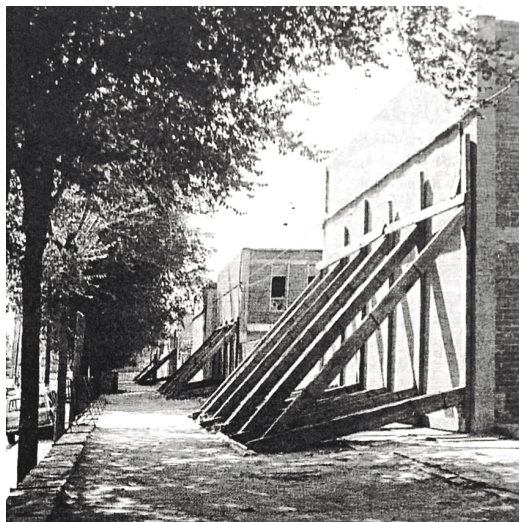
Recalces de los bloques
