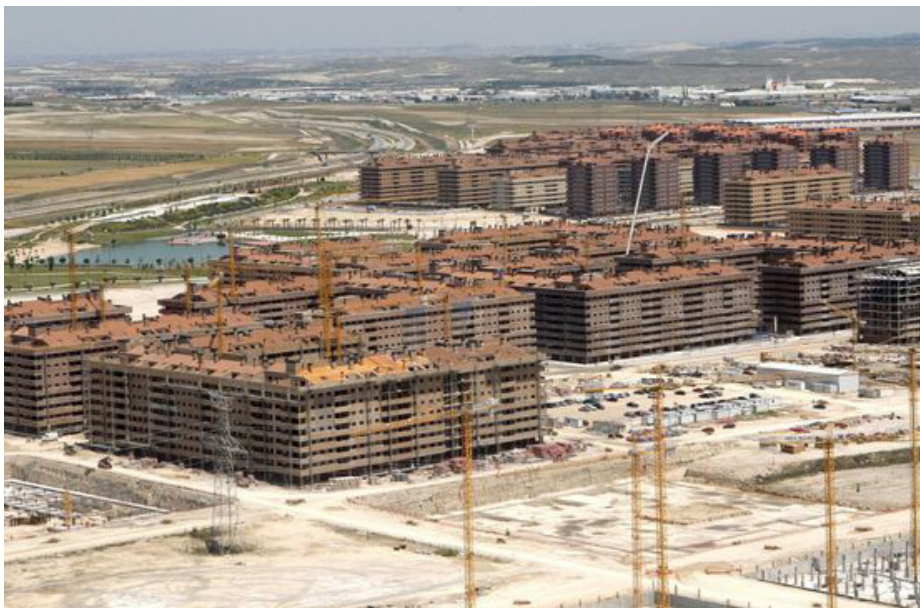
3.1. Urbanización en Construcción en Seseña, Toledo, 2008.
