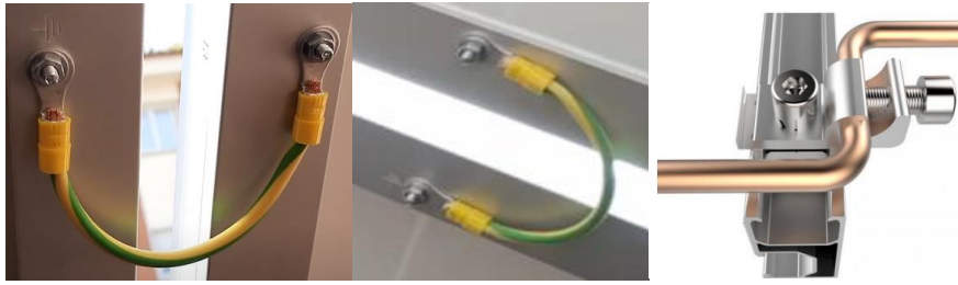
Figura 7.42. Conexión a tierra entre los paneles [40]
