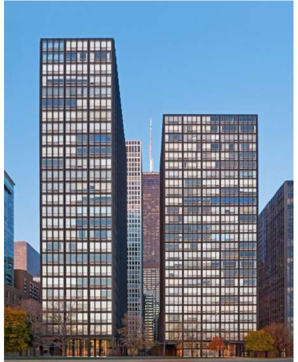
Figura 121: Lake Shore Drive de Mies van der Rohe, 1948-1950.
