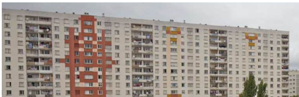
Figura 103: Vista exterior de los bloques de viviendas antes de la intervención.
