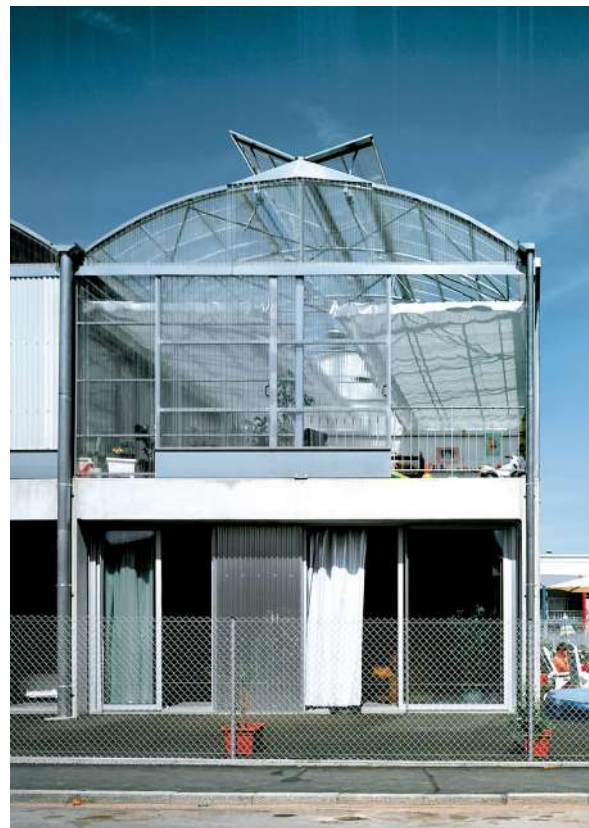
Figura 124: Vista exterior de las viviendas en la ciudad manifiesto de Mulhouse.
