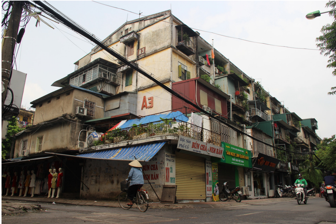
Fig. 219. Self-built apartment modifications in Khu Tập Thể Bắc Thành Công, Hanoi. Source: author, 2019.
