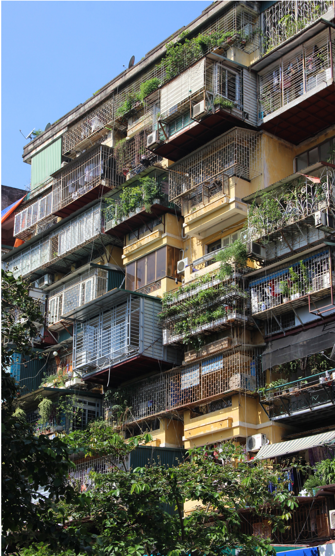
Fig. 229. Self-built apartment modifications in Khu Tập Thể Giảng Võ, Hanoi. Source: author, 2019.
