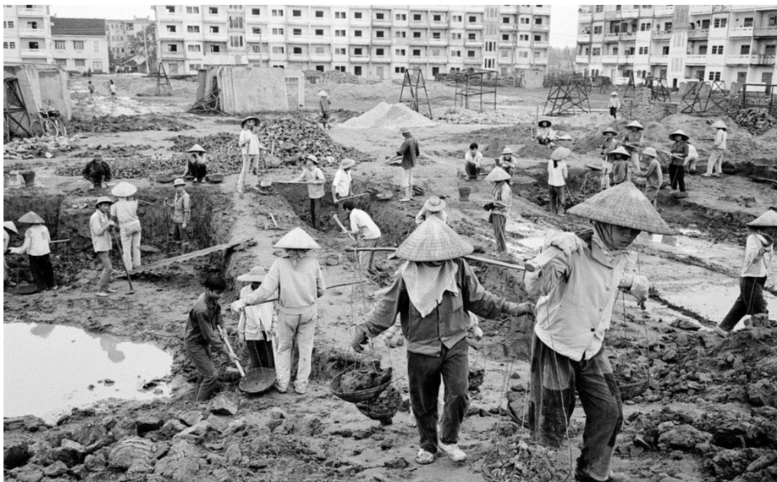
Fig. 214. Abbas Attar, Construcción de una barriada de viviendas socialistas , 1975.
