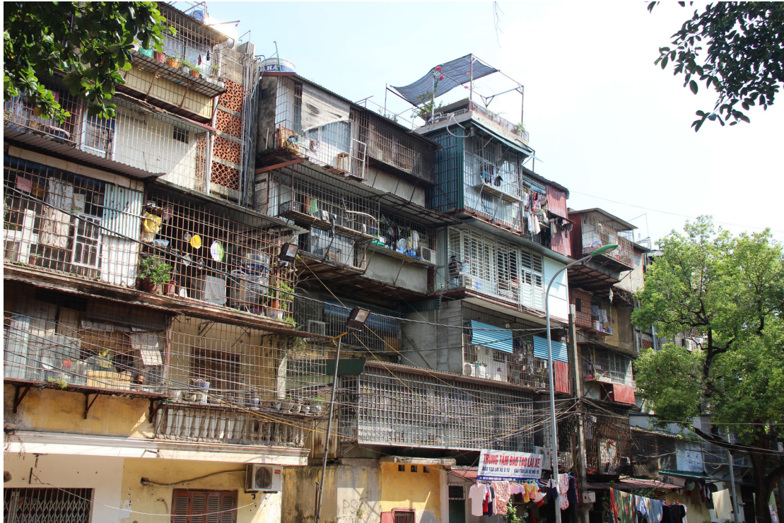
Fig. 220. Self-built apartment modifications in Khu Tập Thể Thanh Xuân Bắc, Hanoi. Source: author, 2019.
