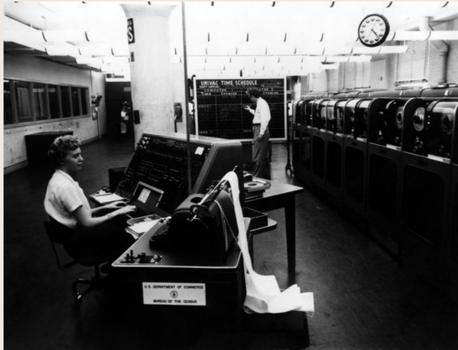
IMAGEN DE UN DE LOS DISPOSITIVOS COMPUTADORES TIPO MAINFRAME (M) UNIVAC I (UNIVERSAL AUTOMATIC COMPUTER) VENDIDOS A LA AGENCIA DEL CENSO DE ESTADOS UNIDOS. UNIVAC I. ECKERT AND MAUCHLY COMPUTER CO. ADQUIRIDA POR REMINGTON RAND. CA. 1951 (A PARTIR DEL 15 DE JUNIO DE ESE AÑO). FUENTE: CORTESÍA DE J.A.N. LEE Y DEL COMPUTER HISTORY MUSEUM (ID: 102640473).
