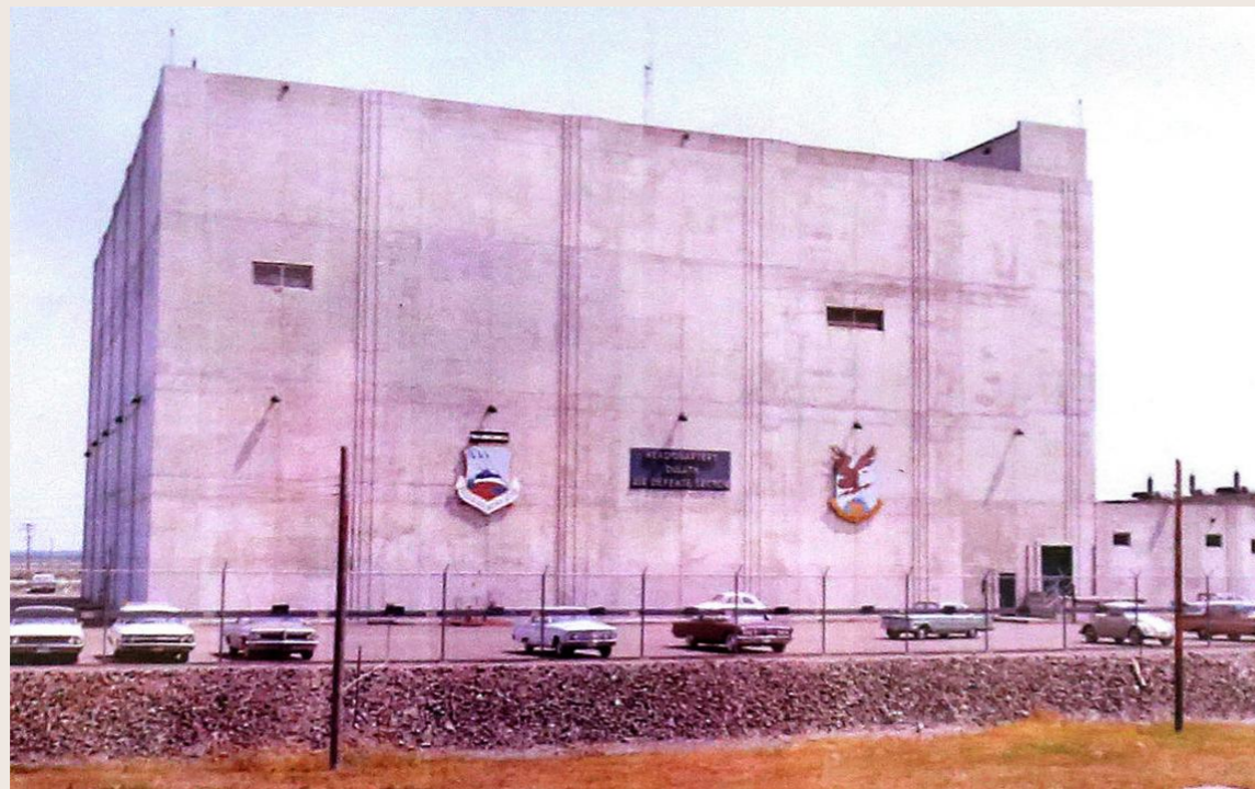
IMAGEN EXTERIOR DE LA CARCASA DE UN DIRECTION CENTER, EN EL QUE SE PUEDE OBSERVAR LA AUSENCIA DE HUECOS, SALVO EL ACCESO AL INTERIOR DE ESTA ARQUITECTURA. CA. 1958. FUENTE: SAGE: SEMI-AUTOMATIC GROUND ENVIRONMENT AIR DEFENSE SYSTEM. ACCESO EL 2 DE MAYO DE 2021 DESDE: HTTPS://WWW.LL.MIT.EDU/ABOUT/HISTORY/SAGE-SEMI-AUTOMATIC-GROUND-ENVIRONMENT-AIR-DEFENSE-SYSTEM
