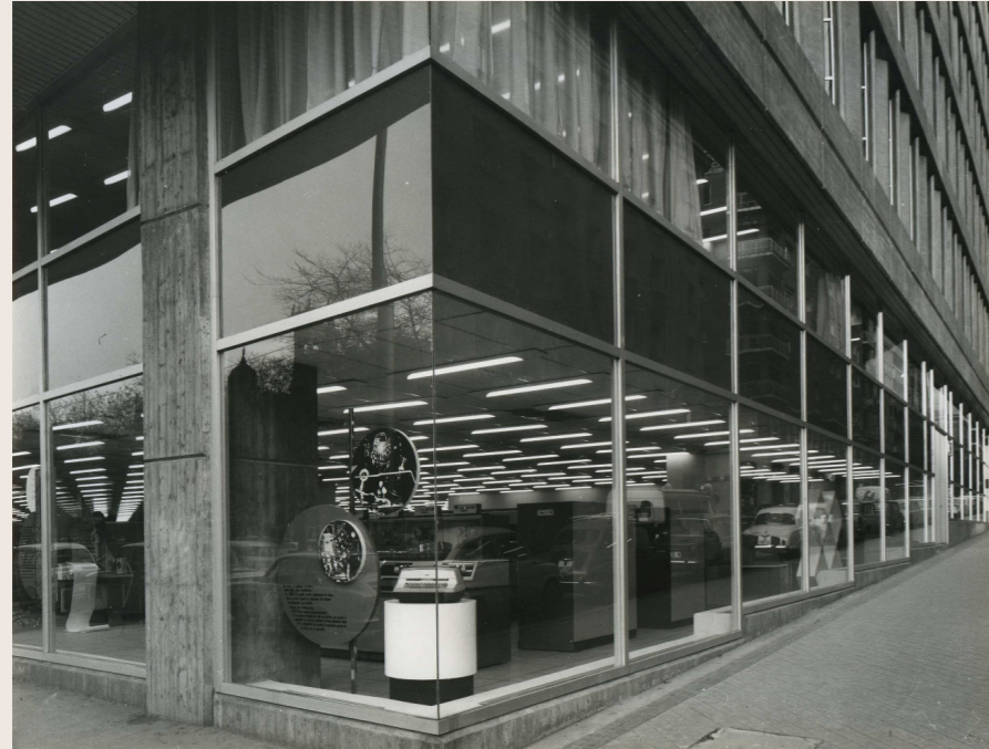
IMAGEN DE DETALLE DE LA ESQUINA DE LA PLANTA BAJA EN CONTACTO CON LA CALLE DE LA SEDE DE IBM ESPAÑA EN EL PASEO DE LA CASTELLANA, 4, MADRID, ESPAÑA. PLANTA BAJA, COMPLETAMENTE ACRISTALADA, TRANSPARENTE QUE DEJABA VER CLARAMENTE SU INTERIOR E INVITABA A ENTRAR Y RECORRER EL ESPACIO REPLETO DE LOS DISPOSITIVOS PRODUCIDOS POR IBM. OBSÉRVESE LA DISOLUCIÓN DE LAS ESQUINAS AL DESPLAZAR LOS PILARES ESTRUCTURALES DE LOS VÉRTICES DE LA PLANTA RECTANGULAR DEL PROYECTO. PROYECTO DE EDIFICIO COMERCIAL EN EL PASEO DE LA CASTELLANA C/V A HERMOSILLA, PROPIEDAD DE FINCOSA (1965-1966-1969) (PROYECTO CAJA 233). MIGUEL FISAC SERNA. FUENTE: CORTESÍA DEL ARCHIVO DE LA FUNDACIÓN FISAC, CIUDAD REAL (ID: IMG473).
