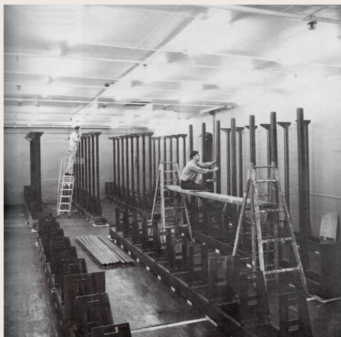
IMAGEN EN BLANCO Y NEGRO DE LA CONSTRUCCIÓN DEL INTERIOR DE LA SALA DEL COMPUTADOR ( COMPUTER ROOM ), CON LOS PASILLOS SERVIDORES Y LOS ESPACIOS SERVIDOS, LOS ARMARIOS O RACKS PARA CADA COMPONENTE DEL DA/DC WHIRLWIND I. LOS BASTIDORES METÁLICOS, COMO SI DE PILARES SE TRATARA, ERAN TODOS DE LAS MISMAS DIMENSIONES Y SERVÍAN PARA DAR SOPORTE A LOS ARMARIOS. 2 DE SEPTIEMBRE DE 1948. JAY WRIGHT FORRESTER. FUENTE: REDMOND, K. C. (1980). EN SMITH T. M. (ED.), PROJECT WHIRLWIND: THE HISTORY OF A PIONEER COMPUTER . BEDFORD: BEDFORD DIGITAL PRESS, P. 97.
