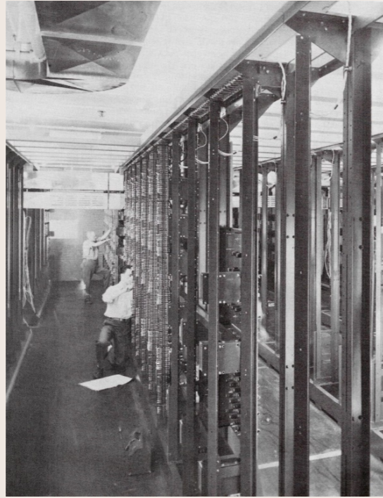
IMAGEN EN BLANCO Y NEGRO DE LA CONSTRUCCIÓN DEL INTERIOR DE LA SALA DEL COMPUTADOR (COMPUTER ROOM). LOS/AS TRABAJADORES COMIENZAN A INSTALAR EL CABLEADO DE LA UNIDAD ARITMÉTICA DEL DEL DA/DC WHIRLWIND I. OTOÑO DE 1948. JAY WRIGHT FORRESTER. FUENTE: REDMOND, K. C. (1980). EN SMITH T. M. (ED.), PROJECT WHIRLWIND: THE HISTORY OF A PIONEER COMPUTER . BEDFORD: BEDFORD DIGITAL PRESS, P. 98.
