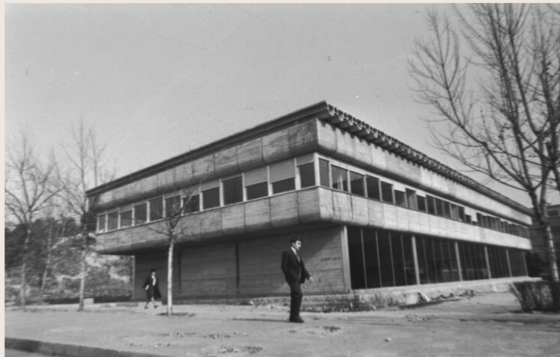
IMAGEN GENERAL DEL CENTRO DE CÁLCULO DE LA UNIVERSIDAD DE MADRID, JUSTO CUANDO SE ESTABAN TERMINANDO LAS OBRAS DE LA CARCASA DEL SOPORTE FÍSICO DEL DISPOSITIVO TECNOLÓGICO. TODAVÍA NO SE HABÍA TRASLADADO LOS COMPONENTES DE IBM. LA FOTOGRAFÍA FUE TOMADA EL 30 DE ENERO DE 1968, Y ESTA ARQUITECTURA DE LA COMPUTACIÓN SE INAUGURÓ OFICIALMENTE EL 7 DE MARZO DE 1969. FOTÓGRAFO: MARÍN SANTOS YUBERO. CORTESÍA DEL ARCHIVO REGIONAL DE LA COMUNIDAD DE MADRID (ID: 0025536).
