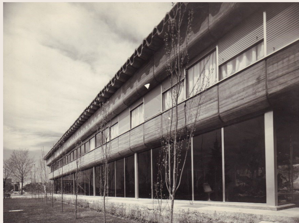
IMAGEN EXTERIOR DEL CCUM. PUEDE VERSE EL VOLUMEN SUPERIOR MACIZO DE HORMIGÓN APOYADO VOLANDO EN EL VOLUMEN INFERIOR LIVIANO DE VIDRIO TRANSPARENTE CUAL ESCAPARATE Y LAS VIGAS-HUESO «VALLADOLID» VOLANDO EN LA CUBIERTA. CA. 1968. MIGUEL FISAC. FUENTE: CORTESÍA DE LA FUNDACIÓN FISAC (ID: 223_E (2)).
