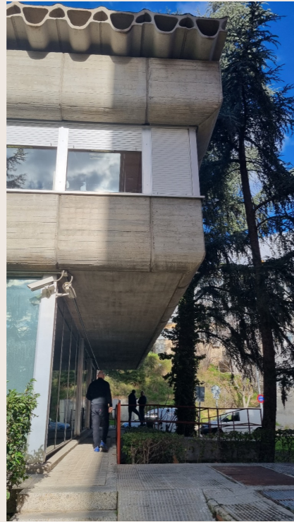
IMAGEN ACTUAL DEL ACCESO PRINCIPAL DE LA FACHADA ESTE DEL ANTIGUO CCUM. SIGUE SIENDO ANGOSTO E INCÓMODO. ACTUALMENTE EL SERVICIO DE INFORMÁTICA, CENTRO DE PROCESO DE DATOS (CPD) DE LA UNIVERSIDAD COMPLUTENSE DE MADRID. MADRID. 15 DE FEBRERO 2023. FUENTE: FOTOGRAFÍA DE LA AUTORA.
