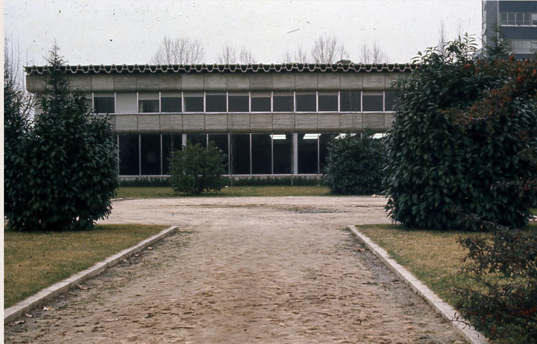
IMAGEN DEL EXTERIOR DE LA FACHADA SUR DEL CCUM TOMADA DESDE LA PLAZA DE LAS CIENCIAS, CON LOS CERRAMIENTOS EXTERIORES ORIGINALES, FIJOS EN LA PLANTA BAJA Y PRACTICABLES PIVOTANTES EN LA PLANTA PRIMERA. NÓTESE LA ILUMINACIÓN ARTIFICIAL ENCENDIDA. CA. 1973. CCUM. MADRID. MIGUEL FISAC. FUENTE: BRIONES MARTÍNEZ, F. [2012]. CREACIÓN DEL CENTRO DE CÁLCULO DE LA UNIVERSIDAD DE MADRID. ACCESO EL 7 DE MARZO DE 2022 DESDE: HTTP://COSASQUEQUIEROCONTAR-FBM.BLOGSPOT.COM/2012/03/CREACION-DEL-CENTRO-DE-CALCULO-DE-LA.HTML
