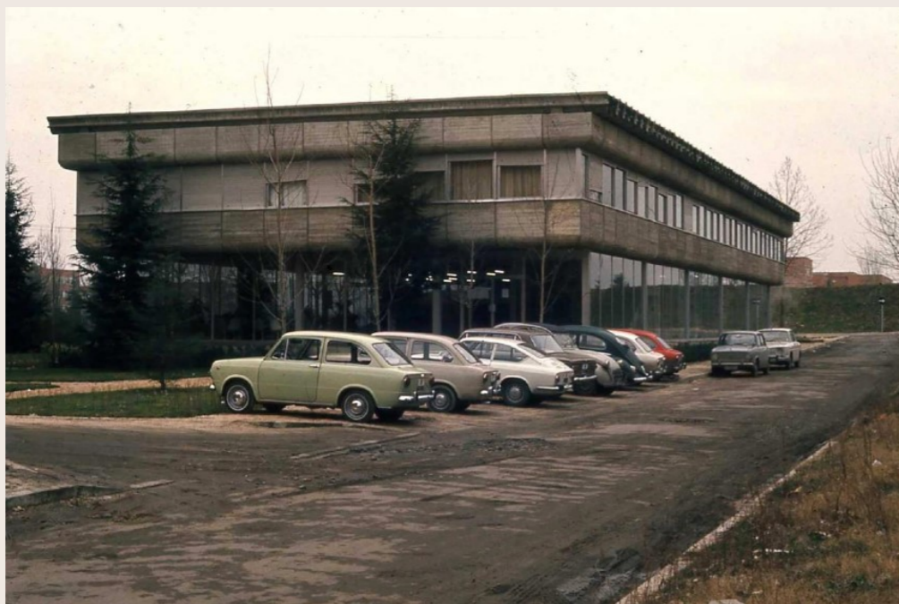
FOTOGRAFÍA DEL NUEVO ALZADO ESTE, EL DE ACCESO, DESDE LA PEQUEÑA PARTE DE LA AVENIDA COMPLUTENSE, DESDE DONDE SE ACCEDÍA AL CCUM TRAS SU CONSTRUCCIÓN EN LA NUEVA PARCELA Y CON LA NUEVA ORIENTACIÓN ESTE-OESTE DEL SOPORTE FÍSICO DEL DISPOSITIVO. CENTRO DE CÁLCULO DE LA UNIVERSIDAD DE MADRID. FACHADAS ESTE, DE ACCESO, Y NORTE. PARTE DE LA AVENIDA COMPLUTENSE, PARANINFO DE LA UNIVERSIDAD. MADRID. 1969. MIGUEL FISAC SERNA. FUENTE: LÓPEZ, A., & MUNARRIZ, J. (2021). EL CENTRO DE CÁLCULO DE LA UNIVERSIDAD DE MADRID (1968-1973): CIENCIA, ARTE Y CREACIÓN COMPUTACIONAL . MADRID: EDICIONES COMPLUTENSE, P.32.
