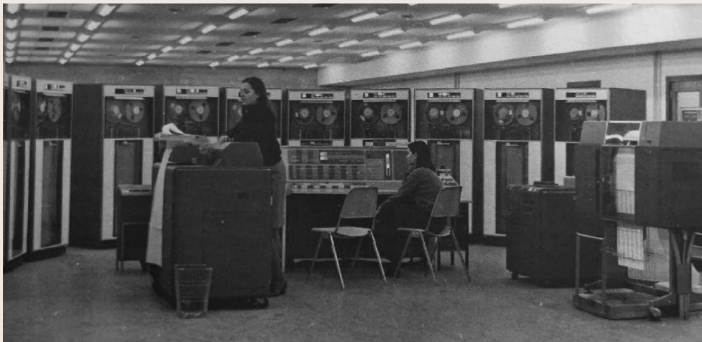
IMAGEN DEL INTERIOR DE LA SALA DE CONTROL O SALA DE MÁQUINAS, CON DOS MUJERES OPERANDO LA CONSOLA PRINCIPAL Y LA IMPRESORA. CCUM. MADRID. MIGUEL FISAC. FUENTE: LÓPEZ, A., & MUNARRIZ, J. (2021). EL CENTRO DE CÁLCULO DE LA UNIVERSIDAD DE MADRID (1968-1973): CIENCIA, ARTE Y CREACIÓN COMPUTACIONAL . MADRID: EDICIONES COMPLUTENSE, P. 19.
