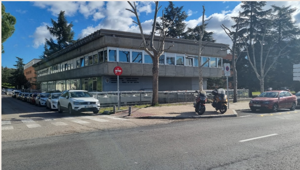
IMAGEN DE LA FACHADA OESTE DEL SOPORTE FÍSICO DEL CCUM, ACTUALMENTE EL SERVICIO DE INFORMÁTICA, CENTRO DE PROCESO DE DATOS (CPD) DE LA UNIVERSIDAD COMPLUTENSE DE MADRID. MADRID. 15 DE FEBRERO 2023. FUENTE: FOTOGRAFÍA DE LA AUTORA.
