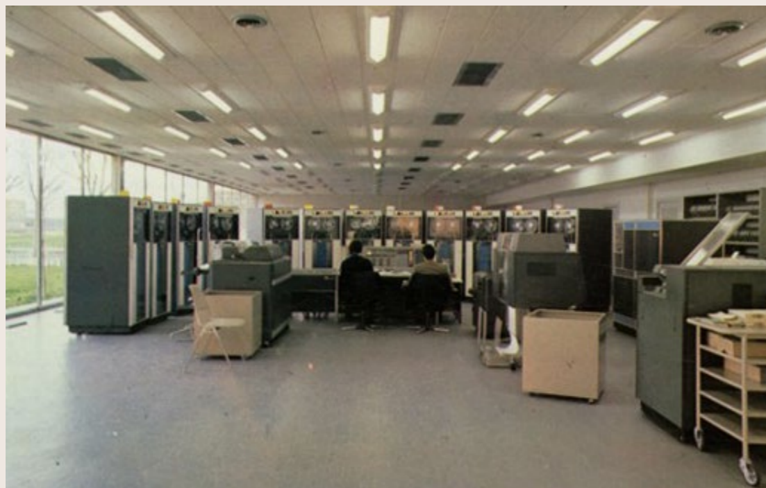
IMAGEN DEL INTERIOR DE LA SALA DE CONTROL O DE MÁQUINAS DEL CCUM CON LA CONSOLA PRINCIPAL Y LAS UNIDADES DE CINTAS Y SUS INDICADORES LUMINOSOS, JUNTO CON LAS PANTALLAS FLUORESCENTES BLANCANIEVES DISEÑADAS POR MIGUEL FISAC. CCUM. MADRID. MIGUEL FISAC. FUENTE: BRIONES MARTÍNEZ, F. (2012). CREACIÓN DEL CENTRO DE CÁLCULO DE LA UNIVERSIDAD DE MADRID. ACCESO EL 7 DE MARZO DE 2022 DESDE: HTTP://COSASQUEQUIEROCONTAR-FBM.BLOGSPOT.COM/2012/03/CREACION-DEL-CENTRO-DE-CALCULO-DE-LA.HTML
