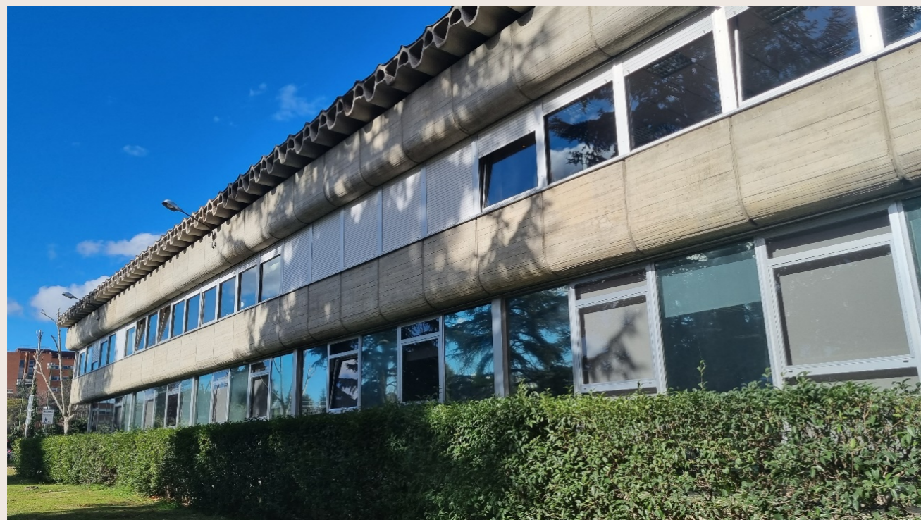
IMAGEN ACTUAL DE LA FACHADA SUR DEL EDIFICIO DEL CCUM CON LA ACTUAL COMPOSICIÓN DE LA FACHADA EN LA PLANTA BAJA. HOY ES EL SERVICIO DE INFORMÁTICA, CENTRO DE PROCESO DE DATOS (CPD) DE LA UNIVERSIDAD COMPLUTENSE DE MADRID. MADRID. 15 DE FEBRERO 2023. FUENTE: FOTOGRAFÍA DE LA AUTORA.
