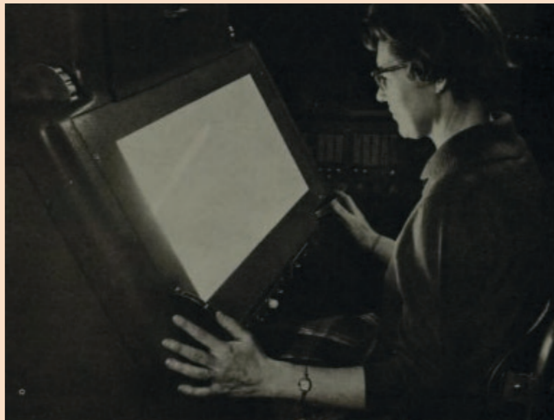
IMAGEN DE UNA MUJER OPERARIA TRANSCRIBIENDO SÍMBOLOS ORTOGRÁFICOS EN TARJETAS PERFORADAS PARA REALIZAR GRÁFICOS Y DIBUJOS POSTERIORMENTE EN UN TELETIPO CONVENCIONAL. DIVISIÓN AEROSPACIAL DE THE BOEING COMPANY. 1964. FUENTE: FETTER, W. A. (1964). COMPUTER GRAPHICS IN COMMUNICATION (1ª ED.). NUEVA YORK: MCGRAW HILL, P. 18.
