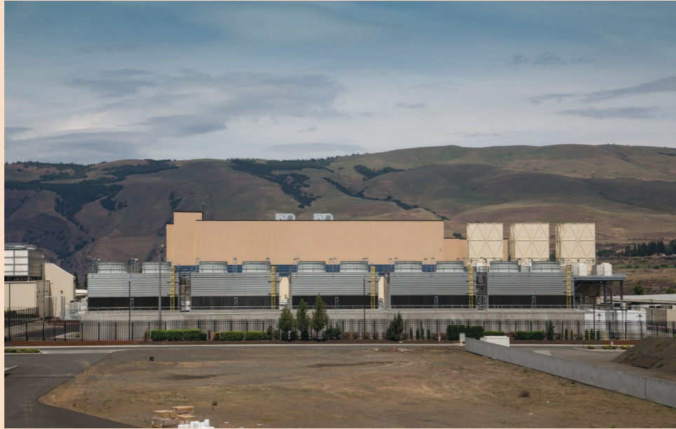
IMAGEN DE LA CARCASA EXTERIOR DE LA PROTO ARQUITECTURA DE LA COMPUTACIÓN DEL GOOGLE DATA CENTER, EN THE DALLES, OREGÓN, ESTADOS UNIDOS. FOTOGRAFÍA DE TONY WEBSTER, 2015. FUENTE: PESTELLINI LAPARELLI, I. (2020). DATA ARCHITECTURES. E-FLUX . ACCESO EL 9 DE MAYO DE 2021 DESDE: HTTPS://WWW.E-FLUX.COM/ARCHITECTURE/INTELLIGENCE/310404/DATA-ARCHITECTURES/
