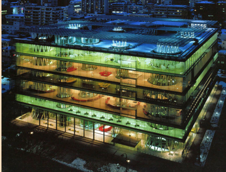
IMAGEN DE LA CARCASA EXTERIOR DEL DISPOSITIVO ARQUITECTÓNICO MEDIATECA DE SENDAI. TOYO ITO & ASSOCIATES. 1995-2001. FUENTE: ACCESO EL 21 DE JULIO DE 2021 DESDE: HTTPS://WWW.JMHDEZHDEZ.COM/2012/01/SENDAI-MEDIATHEQUE-TOYO-ITO-MEDIATECA.HTML
