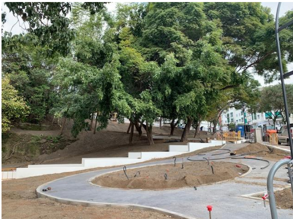
Imagen 23. 'El Jardín de los Sentidos'. Senderos de hormigón impreso. Elaboración propia.
