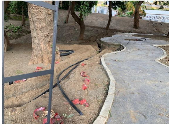
Imagen 26. 'El Jardín de los Sentidos'. Instalación del sistema de riego. Elaboración propia.
