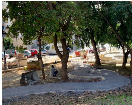
Imagen 24. 'El Jardín de los Sentidos'. Senderos de hormigón impreso. Elaboración propia.
