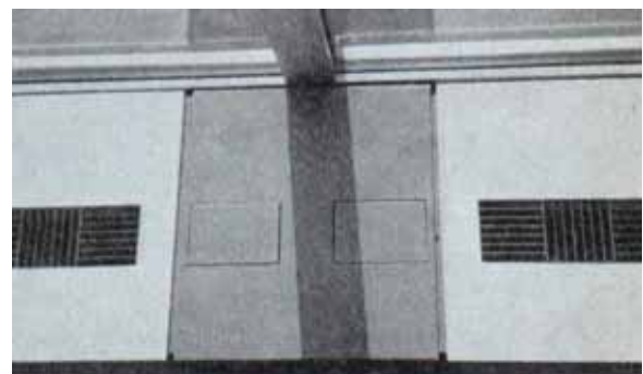
Fig. 126e (izda.). Sección y planta de la fachada y de la partición móvil. Fig. 126f, 126g (dcha.). Fotografías de las unidades de aire acondicionado integradas en la fachada. (W. 1965)
