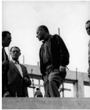
Las obras de construcción de los edificios de la HfG.
