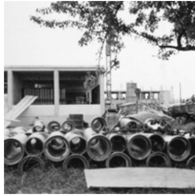
Las obras de construcción de los edificios de la HfG.
