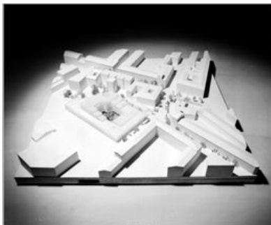
Gino Valle, Herbert Ohl: Proyecto para La Rinascente en Via Carducci. Fig. 207a. Fotografía del modelo del edificio con forma de U escalonada y patio central, sin cubrir. Fig. 207b. Fotografía del modelo del edificio con forma de U escalonada y patio central, con cubierta inclinada de material plástico translúcido. (Fondo del fotógrafo Giorgio Casali en el Archivo Progetti de la Universidad de Venecia)
