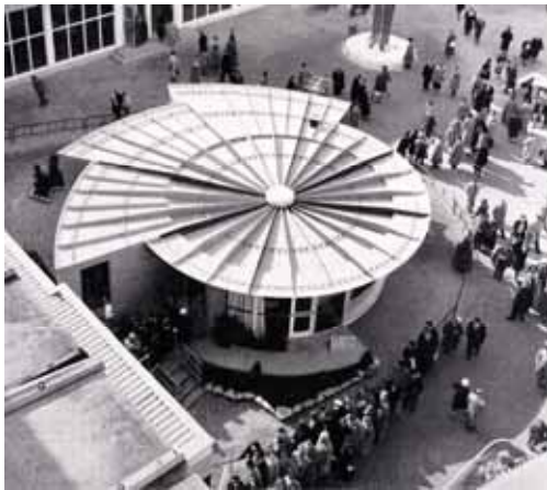
Ionel Schein, R. Coulon, Y. Magnant. Primera vivienda construida completamente con materiales plásticos. Exposition Arts Ménagers en Paris, 1956. Fig. 193a (arriba izda.). Planta. Fig. 193b (arriba). Componentes. Fig. 193c (abajo izda.). Fotografía del prototipo Fig. 193d (abajo dcha.). Fotografías de la construcción. ((s.n.) 1959b)
