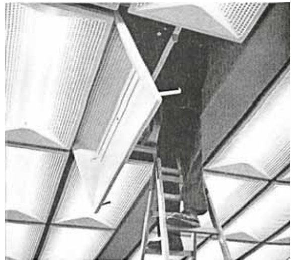
Friedrich Wilhelm Kraemer. Sala de festivales de Farbwerke Hoechst AG, Frankfurt am Main, 1963.
