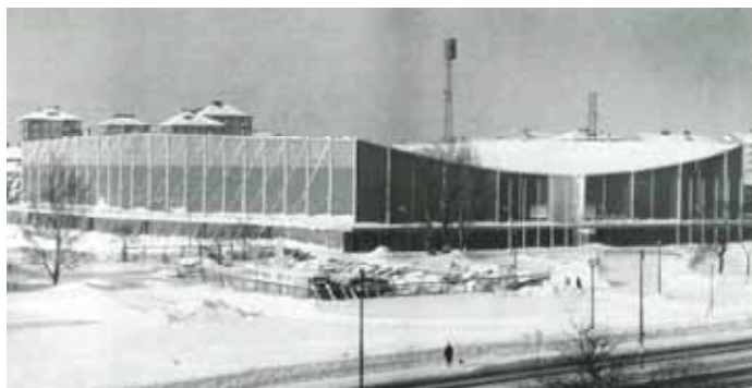
P. Hedquist (arquitecto) y David Jawerth (ingeniero). Cubierta del estadio de hielo de Stokholm-Johanneshov, 1962. Cubierta de 83m de luz, de 21 unidades estructurales tensadas, con una duración prevista de montaje de una semana.
