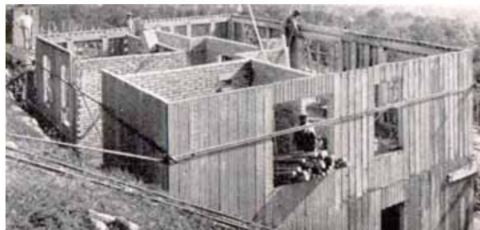
Fig. 94a (dcha.). Karl Kieser. Vivienda en Weinfeld, 1932-1934. Construcción de los cerramientos portantes con el sistema de placas Kieser. ([s.n.] 1934a)
