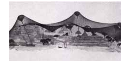
Fig. 279e. Estudiante: Thomas Klumpp. balones elásticos neumáticos como soportes internos que aseguran una distribución continua de la tensión.
