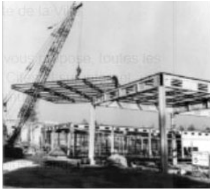
Fig. 369. Jean Duret y Pierre Bussat (arquitectos) y Jean-Maire M. Yokoyama (ingeniero). Sistema de construcción para el pabellón "Comunicación y transportes" de la Expo 64 en Lausana.
