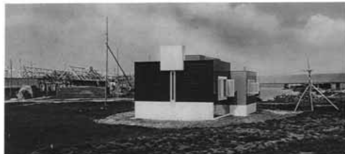
Fig. 4. J.J.P. Oud. Oficina provisional para la obra "Oud Manthesse", Rotterdam. 1923. La fotografía fue empleada por Hannes Meyer para ilustrar "bauen" en bauhaus 4 . (Meyer 1928b)
