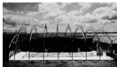
Fig. 280f. Estudiantes: J.N.S. Luck y M.A. Pearson. Arcos tensegríticos paralelos estabilizados lateralmente mediante una red triangular transversal. La membrana se suspende por puntos a intervalos de 3 a 5m bajo la estructura
