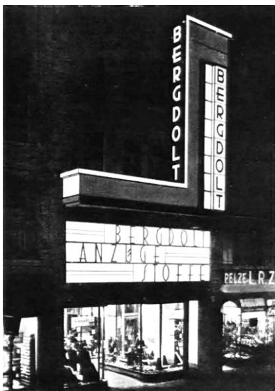
Fig. 3.4.57. Ejemplo del empleo de la sustancia luminosa en arquitectura. Algunas notas sobre luminotecnia. Eduardo Carvajal. Revista Arquitectura , 146. 1931
