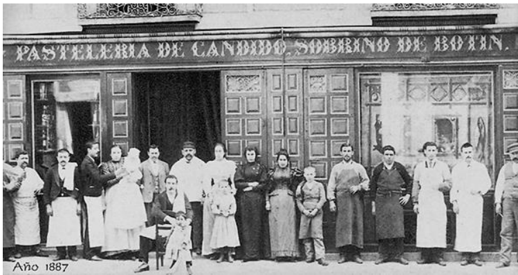
Fig. 3.3.9. Galdosiana del restaurante Casa Botín. Cuchilleros, 1725
