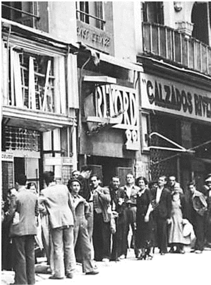
Fig. 3.4.20. Tienda de discos, receptores de radio y gramófonos Rekord. Av. Pi y Margall, 22. Luis Martínez Feduchi, 1931. Imagen tras bombardeos durante la Guerra Civil en el que puede comprobarse que el farol de vidrio ha sido completamente destruido, permaneciendo únicamente la estructura de anclaje a fachada. Archivo Rojo y diario ABC 31.03.1937
