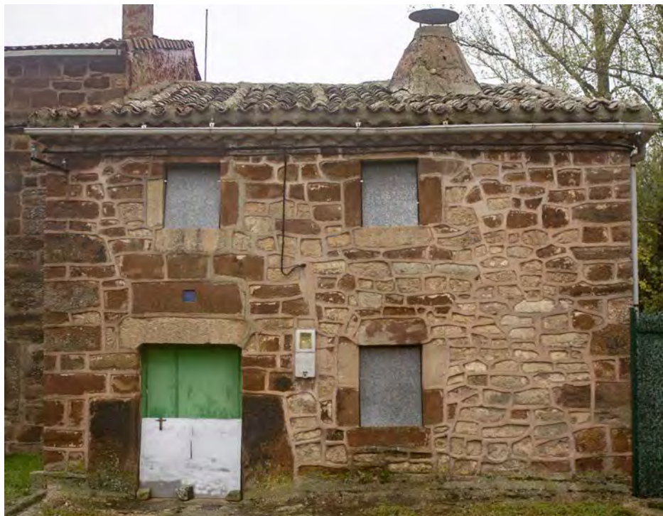
Figura 3.3.2.: casa serrana en Mazueco de Lara.
