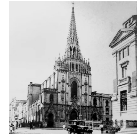
Iglesia de los Jesuitas en la Coruña
