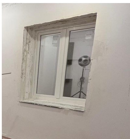
Figura 33. Hueco en el que está montada la ventana en el recinto emisor.
