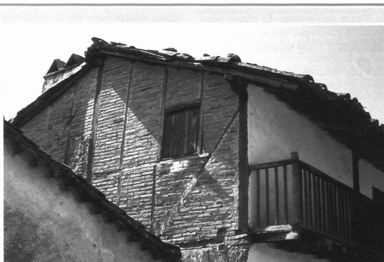
Detalle de la galería y un muro lateral del Parador de Arroyocastaño, Mombeltrán.
