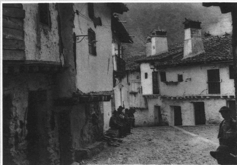
La plaza de Guisando a principios de siglo. Foto Wunderlich. « Las cubiertas, de las que sale una gran chimenea, son poco inclinadas, y las puertas de las casas, grandes, con dintel monolítico de piedra, a cuyos lados hay sendos poyos para sentarse. Algunas de las fachadas aparecen blanqueadas; en otras la piedra queda al descubierto» (Leopoldo Torres Balbás, 1933).
