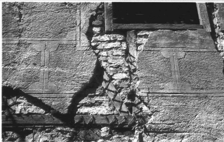
Detalle de una fachada de El Arenal. Se aprecian detalles del entramado, la plemeniería y el revoco.
