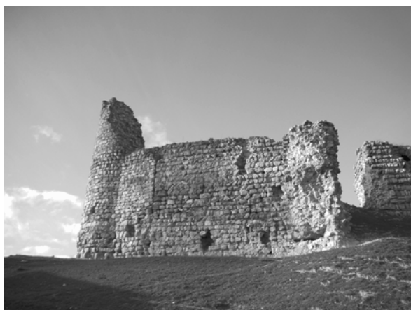
Fig. 1 – Vista del paramento sur del recinto principal del castillo.
