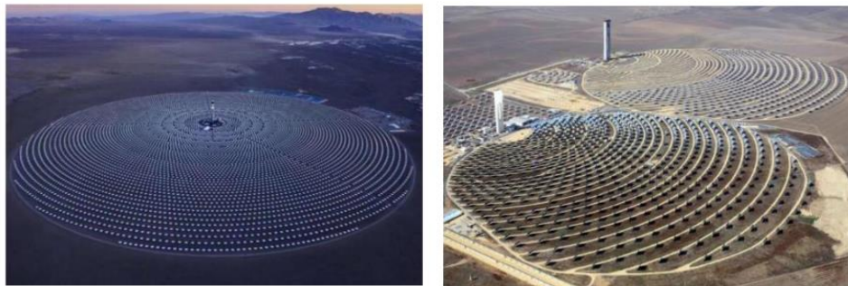
Figura 19: Distribución envolvente (derecha) y distribución polar (izquierda) del campo de helióstatos [20]
