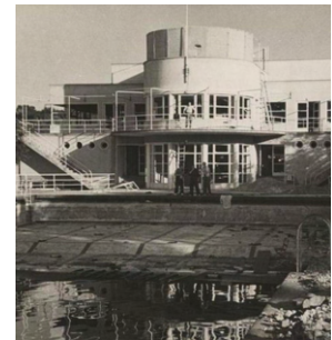
Fig. 3.27. Piscina de popa durante las obras (ca. 1930)
