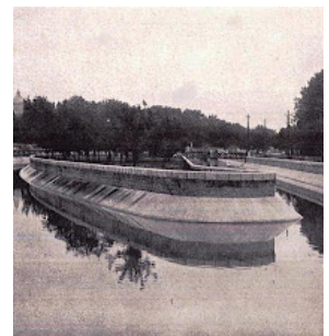
Fig. 3.6. Muros perimetrales isla del Manzanares
