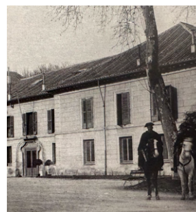
Fig. 3.9. Fachada principal del palacete de la Casa de Campo (1931)
