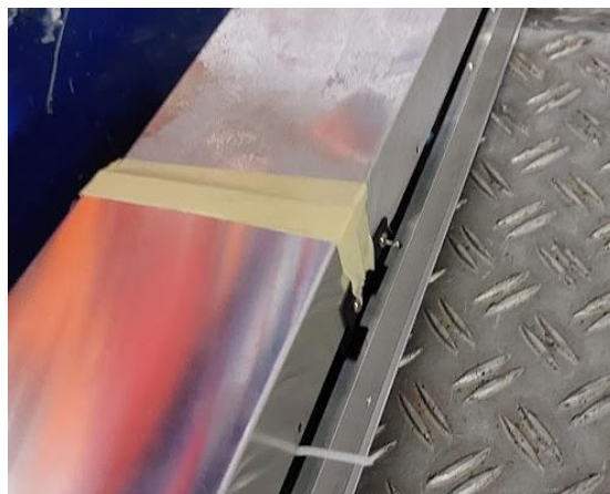
Figura 117. Recubrimiento con cinta de los saltos entre cubiertas de protección.
