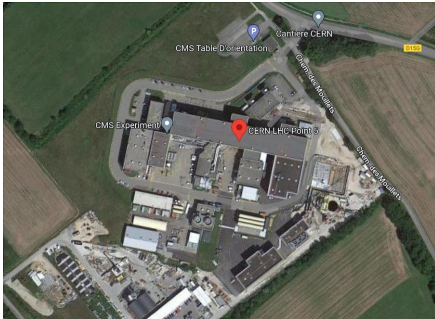
Figura 3. Vista satélite de la superficie del Punto 5 del CERN. [Imagen extraída de Google Maps]
