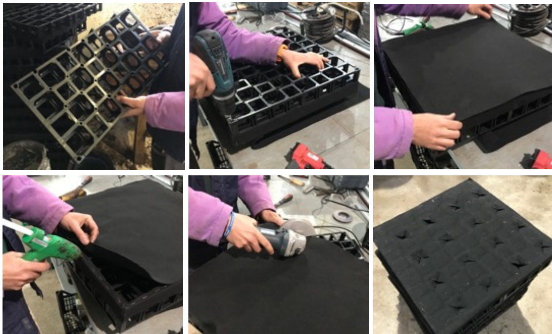
Figura 14: Proceso constructivo del sistema modular en plástico
