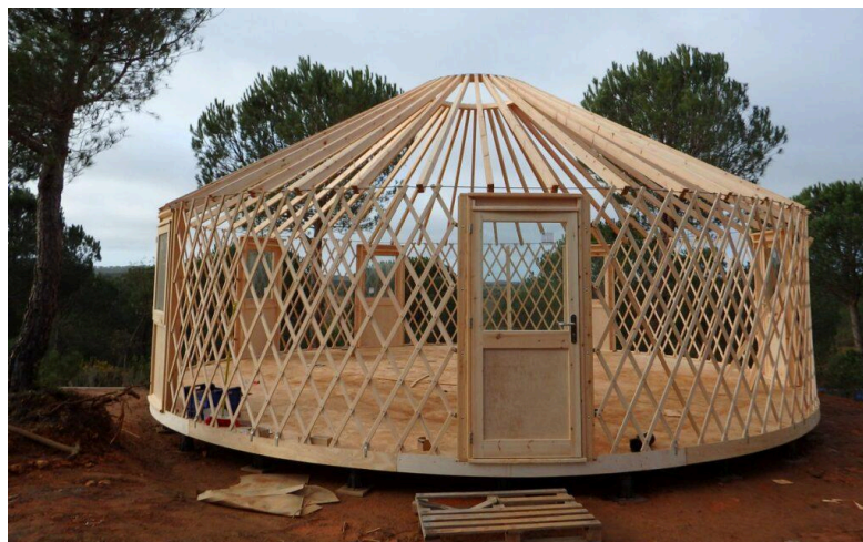
Fig 33. Fotografía del armazón descubierto de la estructura de una yurta [15]
