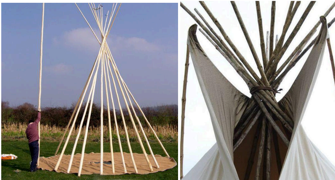
Fig 30 y 31. Fotografías de una estructura de tipi sin recubrimiento y un zoom de la unión superior de sus elementos [31]
