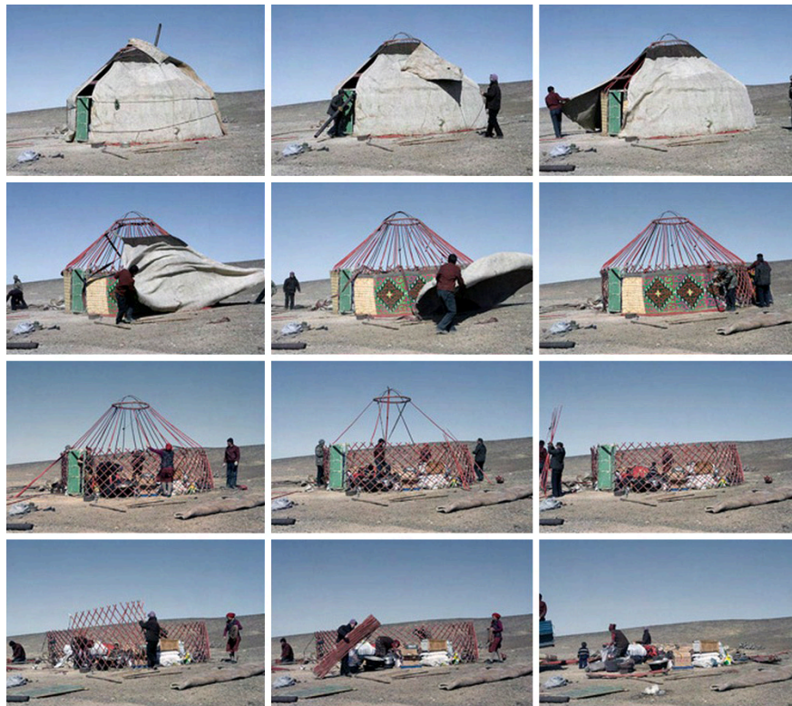
Fig 34. Fotografías del time-lapse de la construcción de una yurta tradicional [15]
