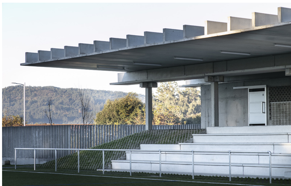
2.1.3 Secuencia de las vigas de la cubierta. A Gandareira, Carlos Pita y Abraham Castro, Silleda, 2018
