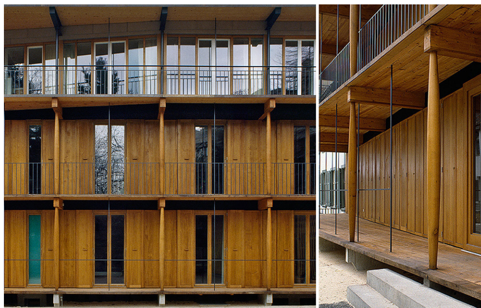
2.4.26 - 2.4.27 Vista de la fachada y de la columna del edificio Hebelstrasse. Herzog & de Meuron, Basilea, 1987
