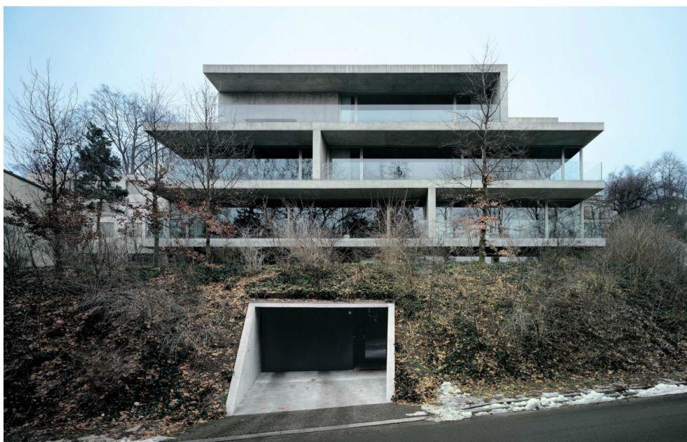
2.2.4 Vista frontal del edificio Forsterstrasse con la expresión de los muros y forjados. Christian Kerez, Zúrich, 2003
