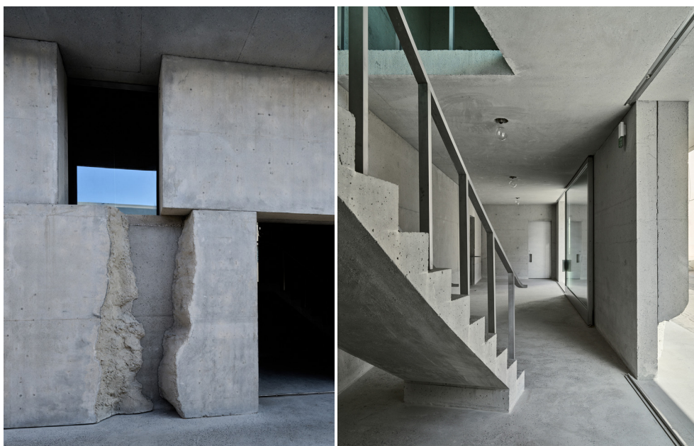
2.3.20 - 2.3.21 Detalle del doble muro de hormigón en el Qaysariyah Suq. Anne Holtrop, Muharraq, 2020
