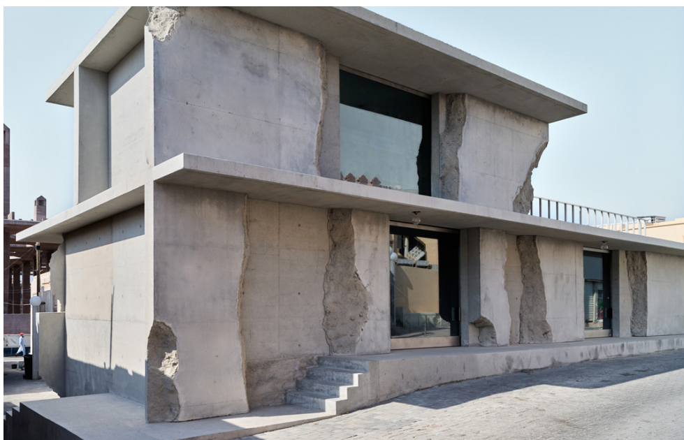
2.3.16 Vista exterior del Qaysariyah Suq con el doble muro de hormigón. Anne Holtrop, Muharraq, 2020
