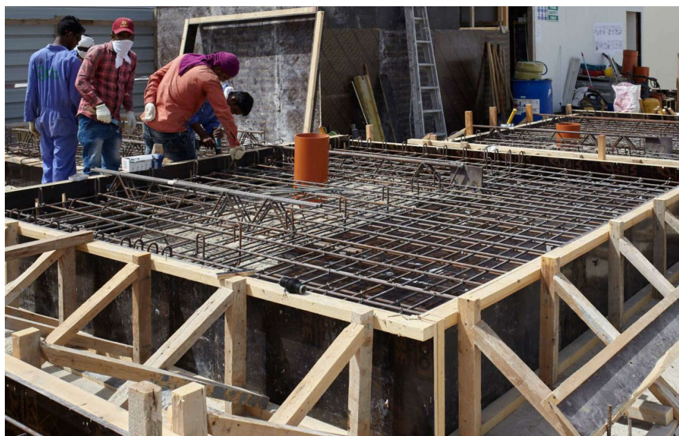
2.3.15 Armadura de las piezas de los forjados para el Green Corner Building. Anne Holtrop, Muharraq, 2020
