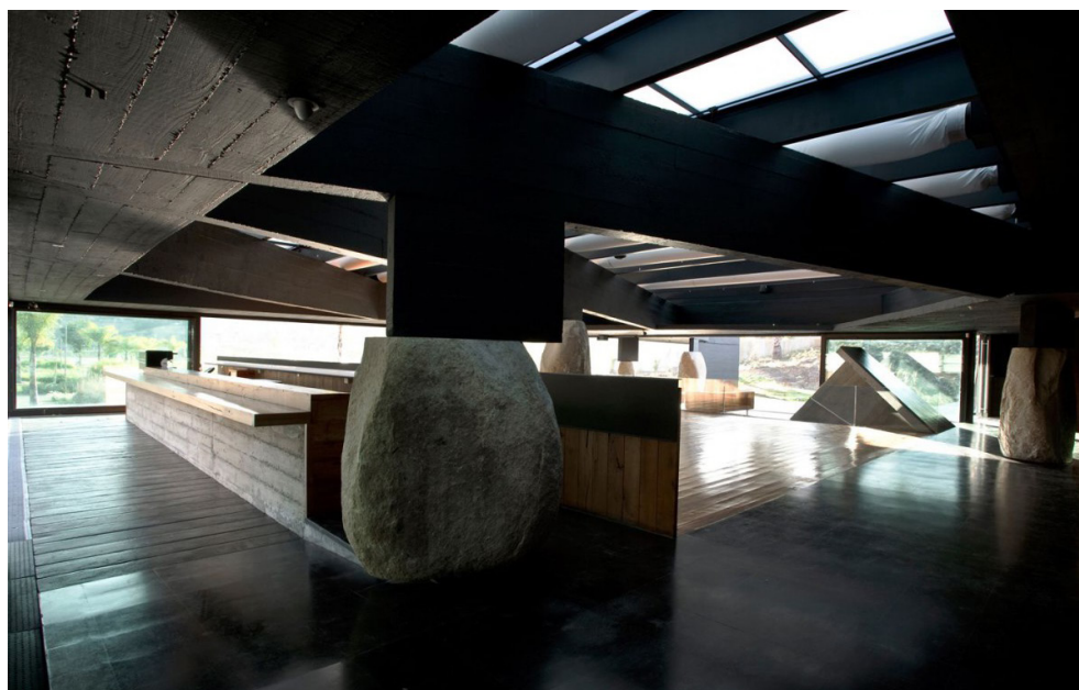
2.5.20 Apoyo de la estructura de hormigón en la piedra. Restaurante Mestizo, S. Radic, Santiago de Chile, 2007
