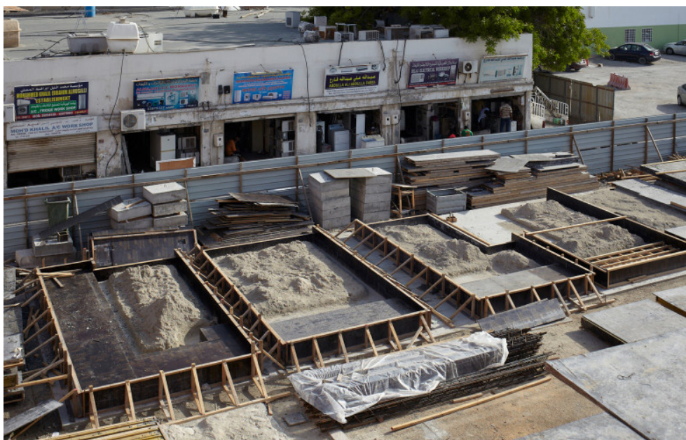
2.3.6 Ejecución de los muros prefabricados con encofrado de arena. Anne Holtrop, Muharraq, 2020
