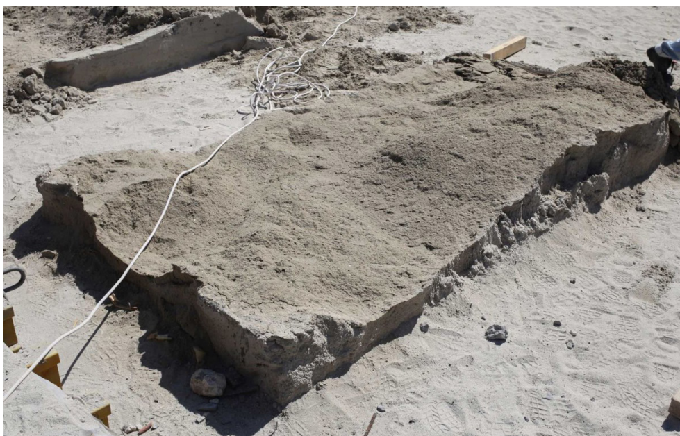
2.3.12 Huella del encofrado de arena para el Green Corner Building
