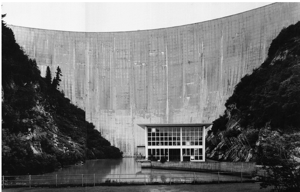
2.2.2 Fotografía de Christian Kerez publicada en "Die kraftwerkbauten im kanton graubünden", Suiza, 1991
