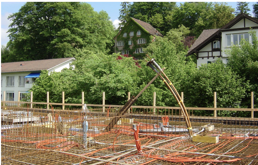
2.2.16 Imagen de la construcción, cable tensor para la suspensión de un muro
