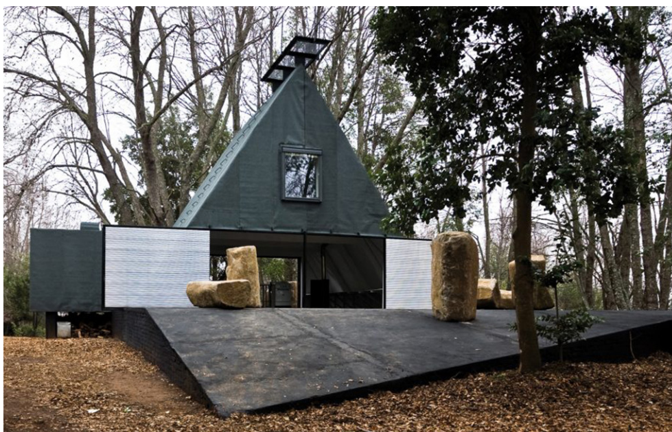
2.5.6 Los bloques de piedra en la entrada de la Casa A. Smiljan Radic, Vilches, 2008
