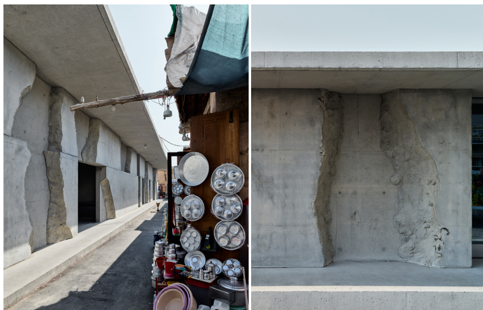
2.3.17 - 2.3.18 Vista exterior del Qaysariyah Suq con el doble muro de hormigón. Anne Holtrop, Muharraq, 2020
