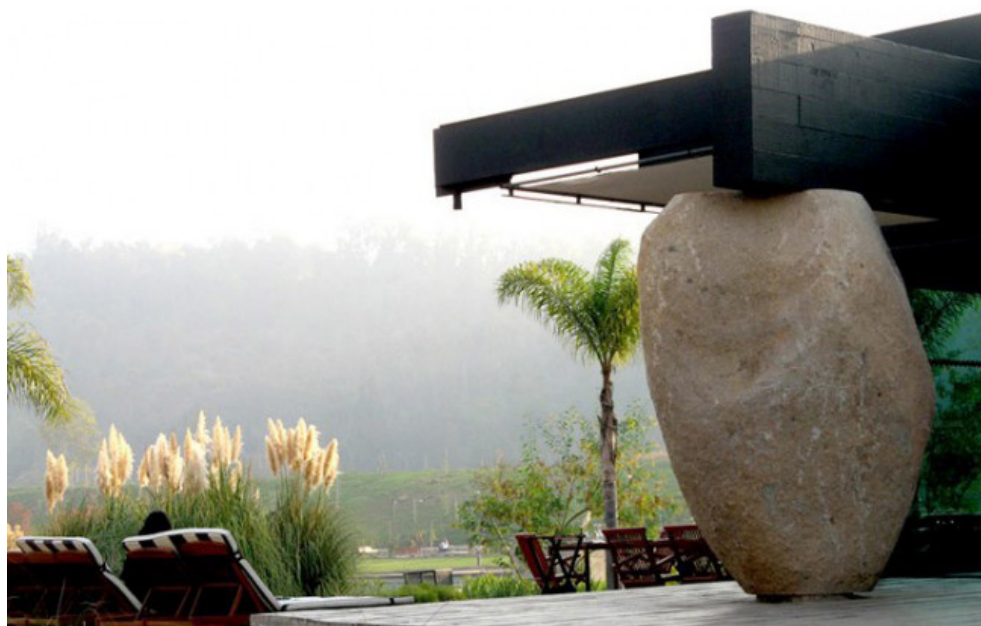
2.5.13 El bloque de granito como soporte estructural en el Mestizo, Smiljan Radic, Santiago de Chile, 2007
