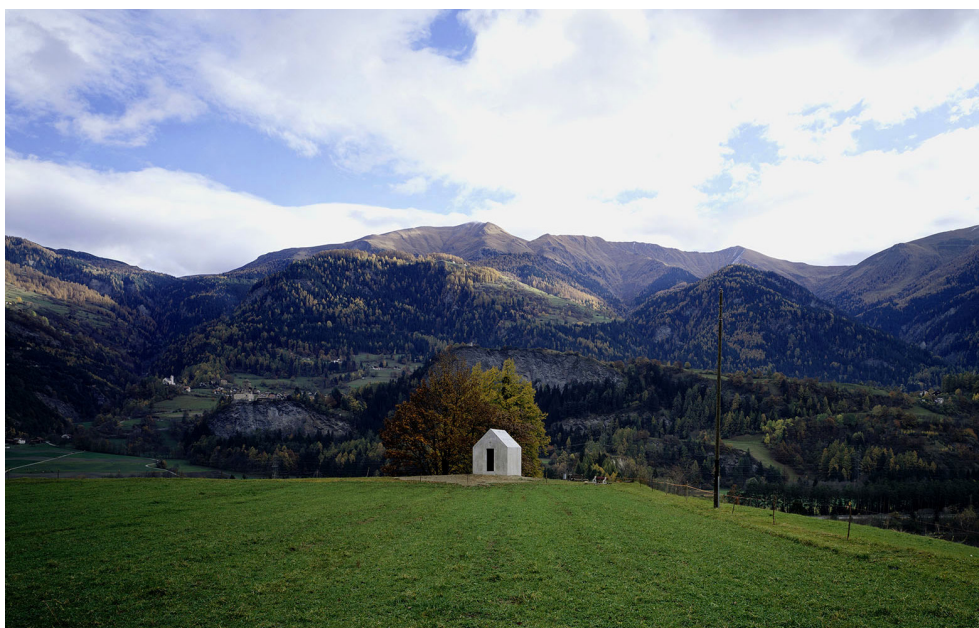
2.2.3 Vista general de la Capilla Oberralta. Christian Kerez, Oberrealta Realta, 1992
