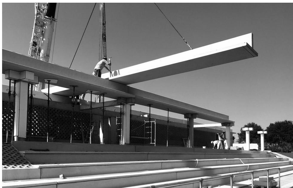
2.1.11 Montaje de la primera viga de la cubierta. A Gandareira, Carlos Pita y Abraham Castro, Silleda, 2018
