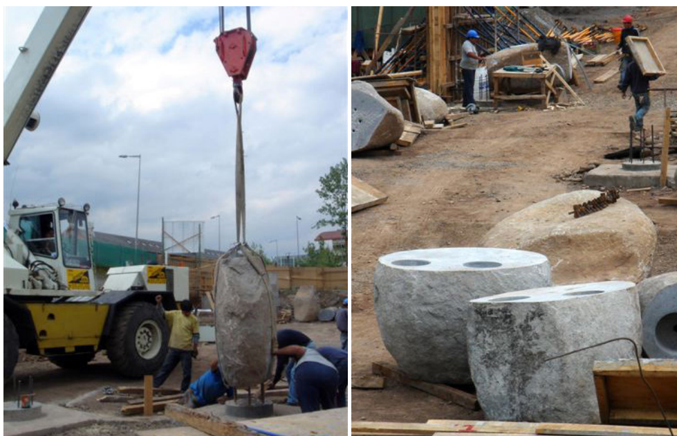
2.5.22 - 2.5.23 Corte y montaje de los bloques de piedra
