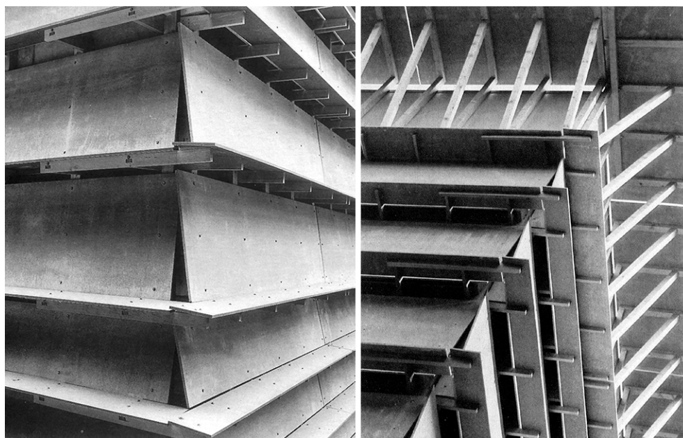
2.4.9 - 2.4.10 Detalles de la fachada del edificio Ricola. Herzog & de Meuron, Laufen, 1987
