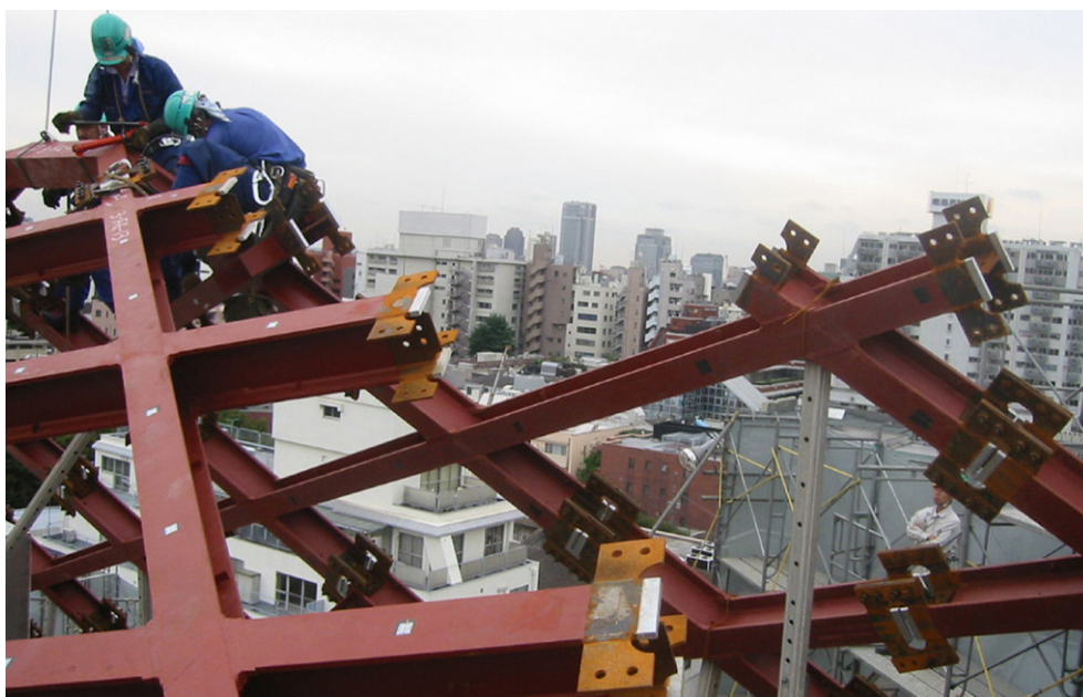
2.4.28 Construcción de la estructura del edificio Prada Aoyama. Herzog & de Meuron, Tokyo, 2003
