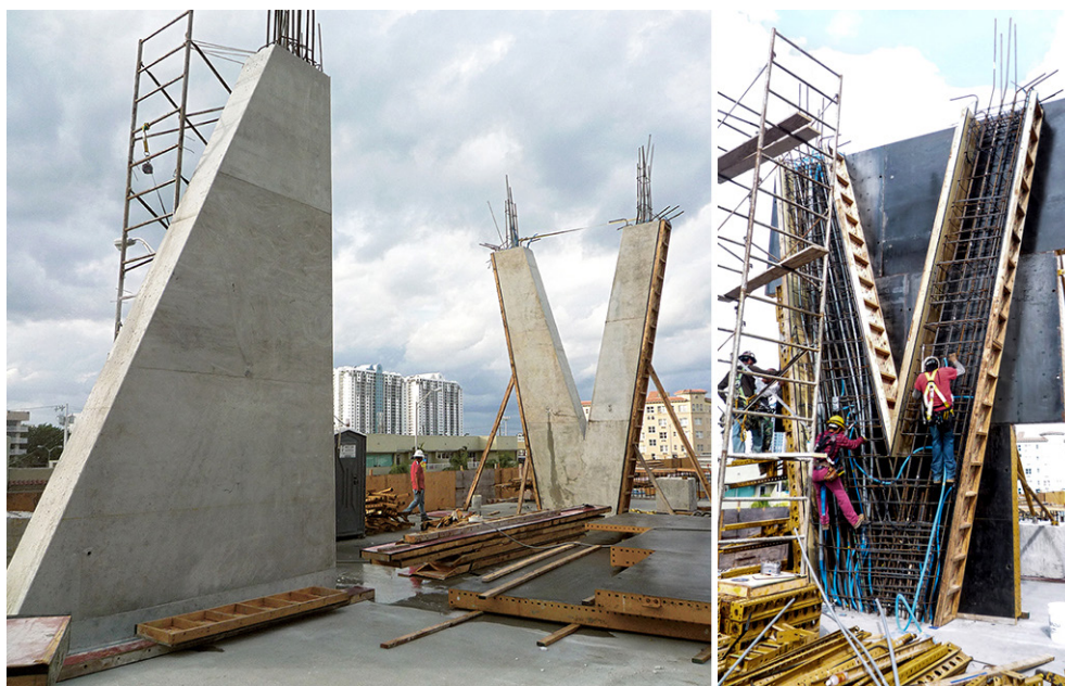
2.4.37 - 2.4.38 Construcción y armaduras de los pilares del 1111 Lincoln Road. Herzog & de Meuron, Miami, 2010
