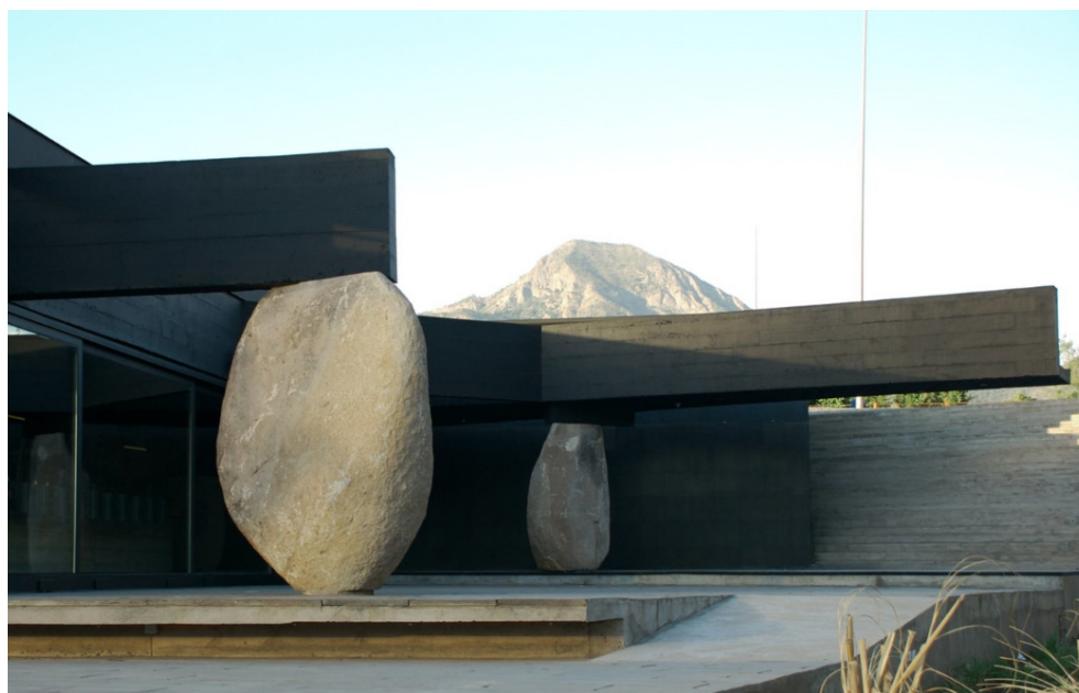
2.5.15 El bloque de granito como soporte estructural. Restaurante Mestizo, Smiljan Radic, Santiago de Chile, 2007
