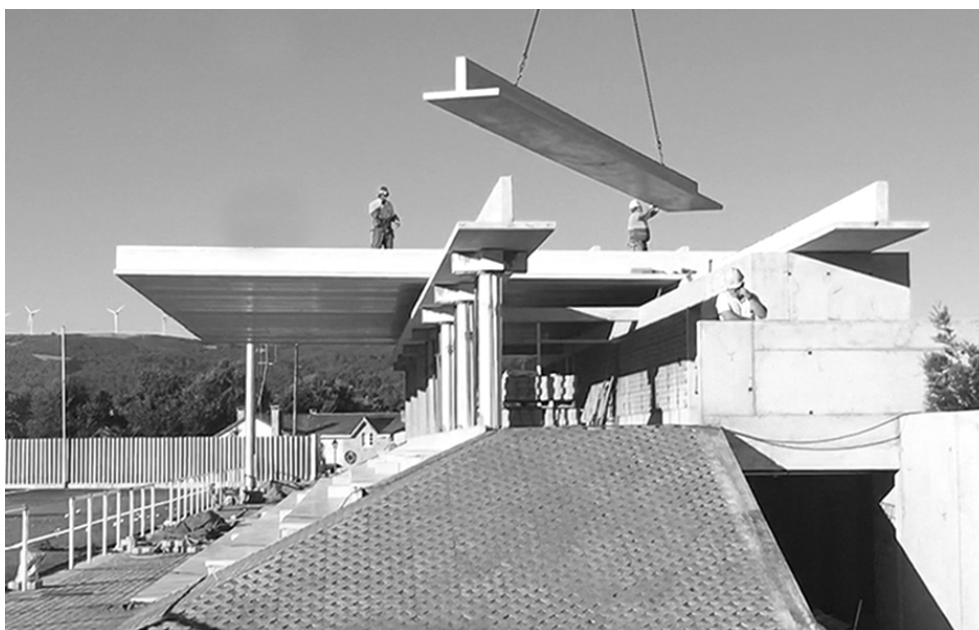
2.1.7 Montaje de las vigas durante la obra. A Gandareira, Carlos Pita y Abraham Castro, Silleda, 2018
