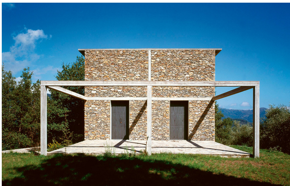
2.4.3 Vista de la estructura de hormigón y muros de piedra de la Stone House. Herzog & de Meuron, Tavole, 1978
