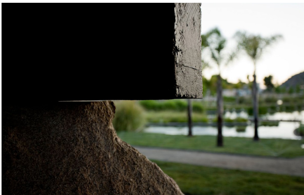
2.5.21 Detalle de encuentro del hormigón con la columna de piedra. Mestizo, Radic, S. de Chile, 2007
