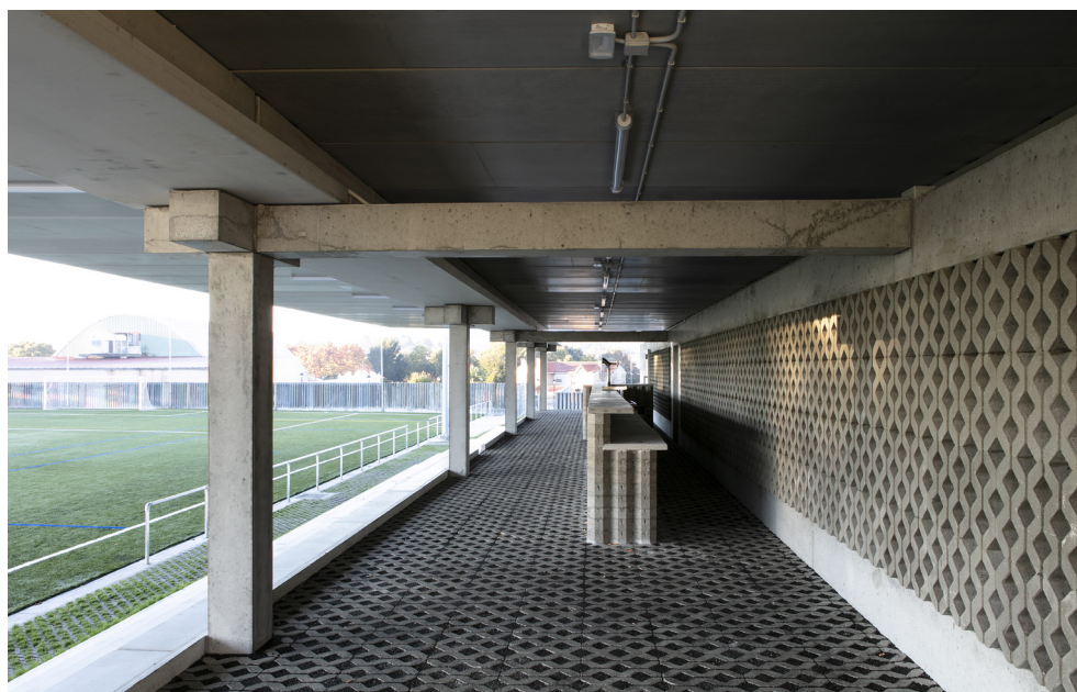
2.1.6 Vigas de arriostamiento de los pilares. A Gandareira, Carlos Pita y Abraham Castro, Silleda, 2018
