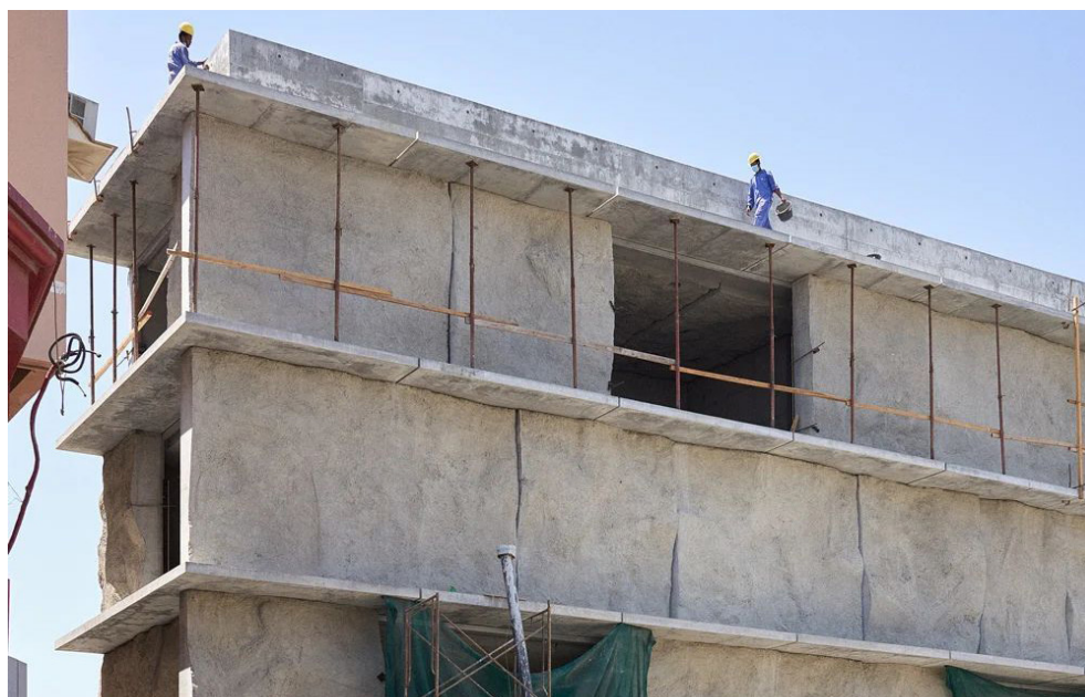
2.3.10 Imagen de la construcción del edificio Green Corner Building. Anne Holtrop, Muharraq, 2020
