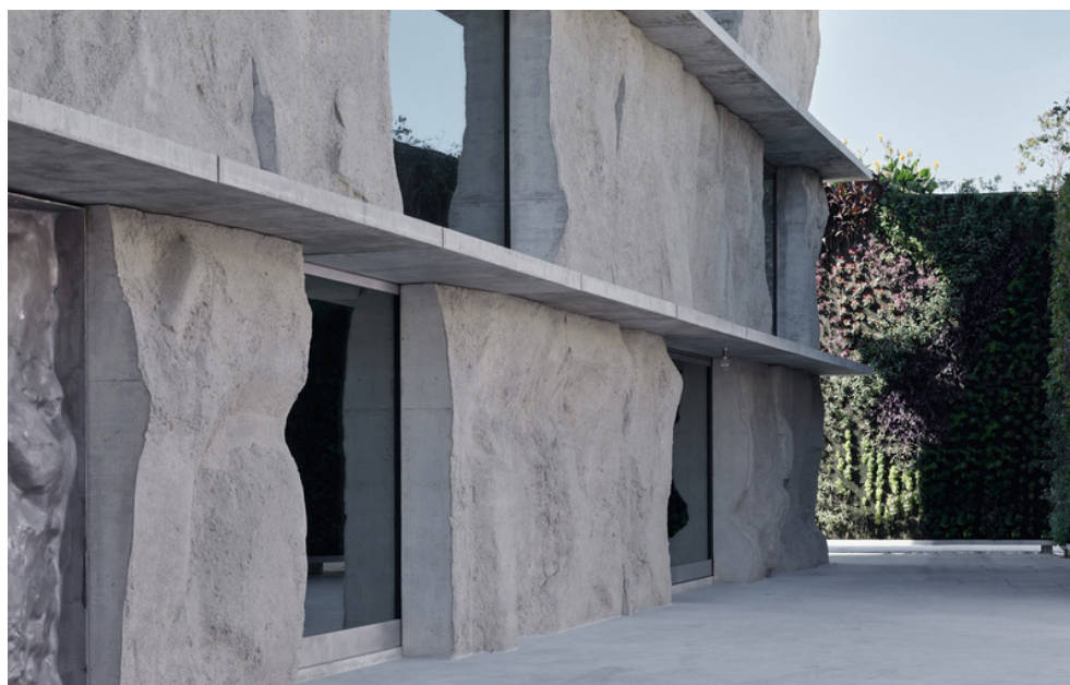
2.3.3 Detalle de la entrada en el Green Corner Building, Anne Holtrop, Muharraq, 2020
