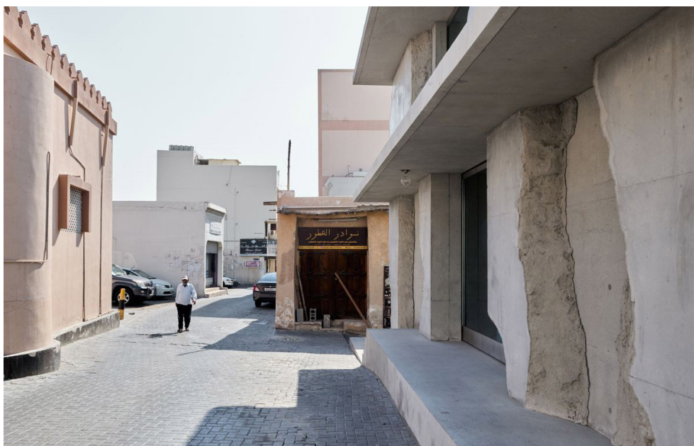
2.3.19 Vista exterior del Qaysariyah Suq con el doble muro de hormigón. Anne Holtrop, Muharraq, 2020
