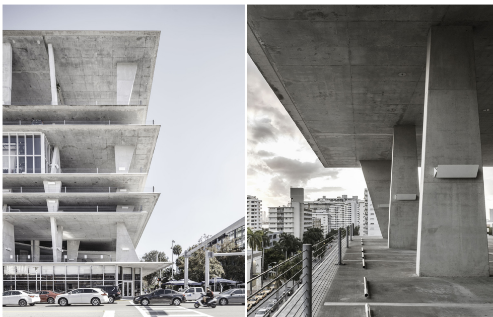
2.4.34 - 2.4.35 Estructura del edificio 1111 Lincoln Road. Herzog & de Meuron, Miami, 2010
