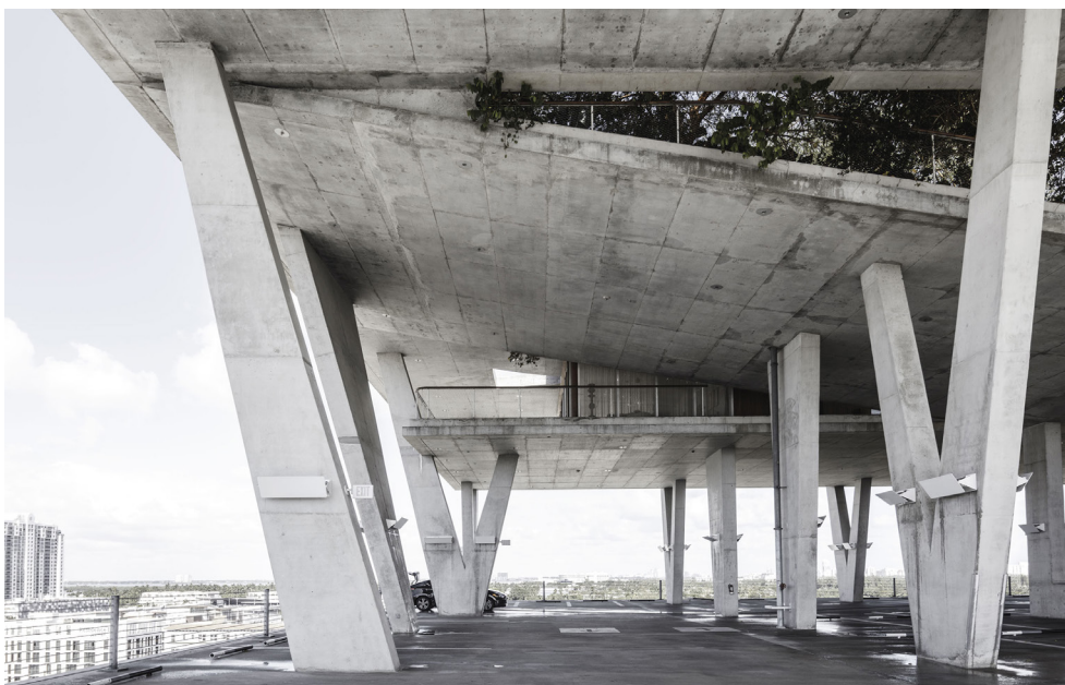
2.4.43 Espacio y estructura en el edificio 1111 Lincoln Road. Herzog & de Meuron, Miami, 2010
