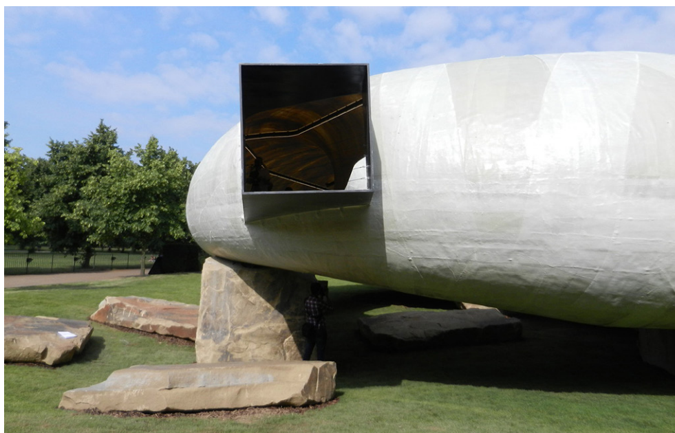
2.5.11 Vista de detalle de los apoyos en la Serpentine Gallery. Smiljan Radic, Londres, 2014
