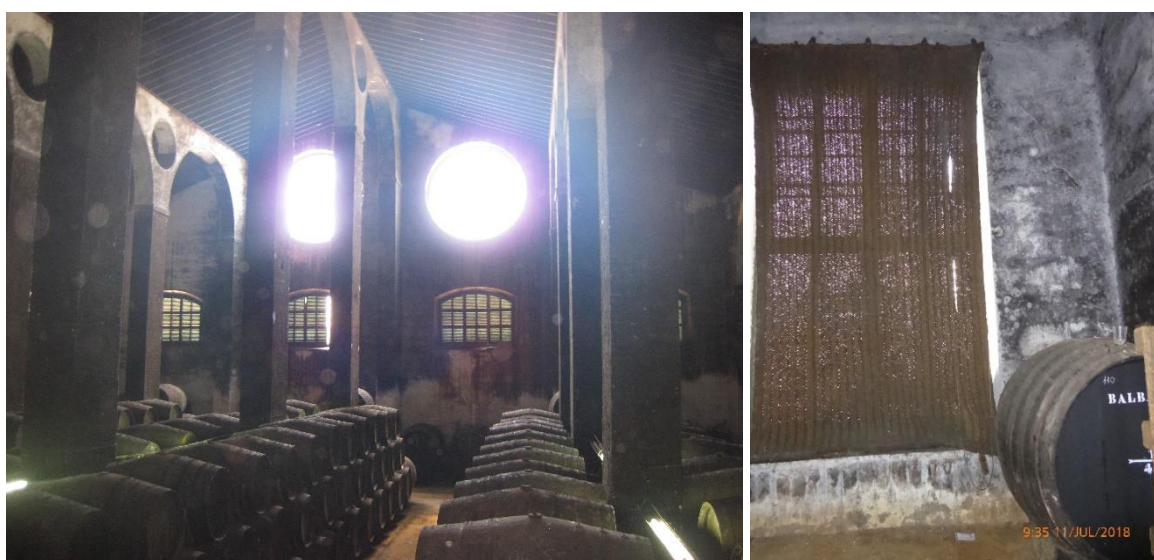
Figura 13. Detalle óculos de ventilación (izquierda) y persianas de esparto (derecha)
