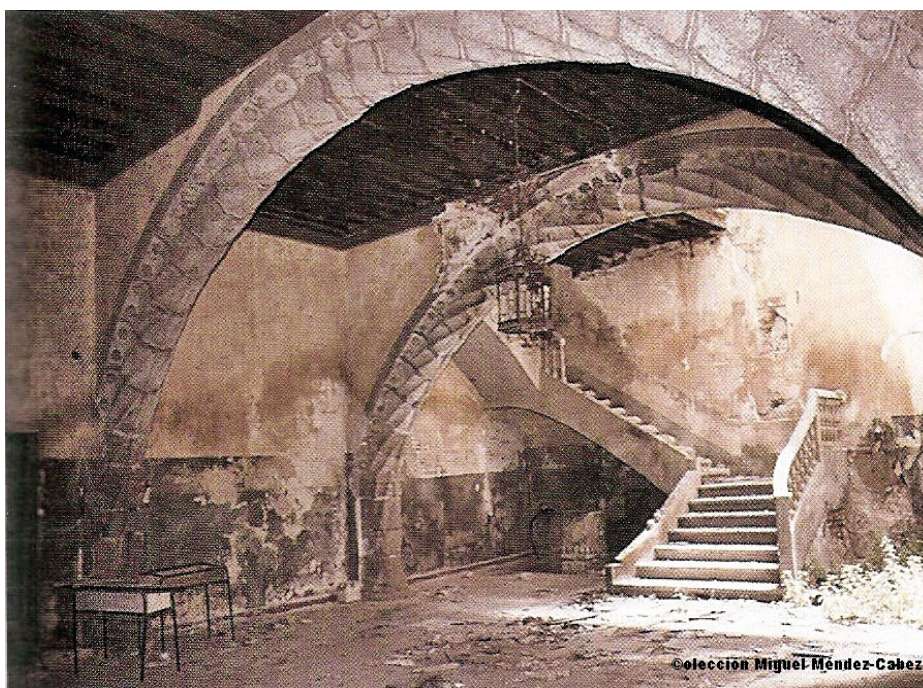
[Fig.61] Fotografía del zaguán del Palacio de Villatoya previa a su restauración.
