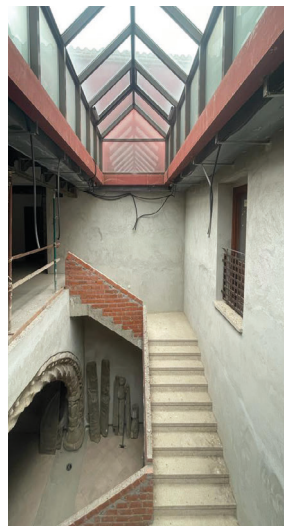
[Fig.60] Fotografías del estado actual del Palacio de Villatoya. Elaboración propia.
