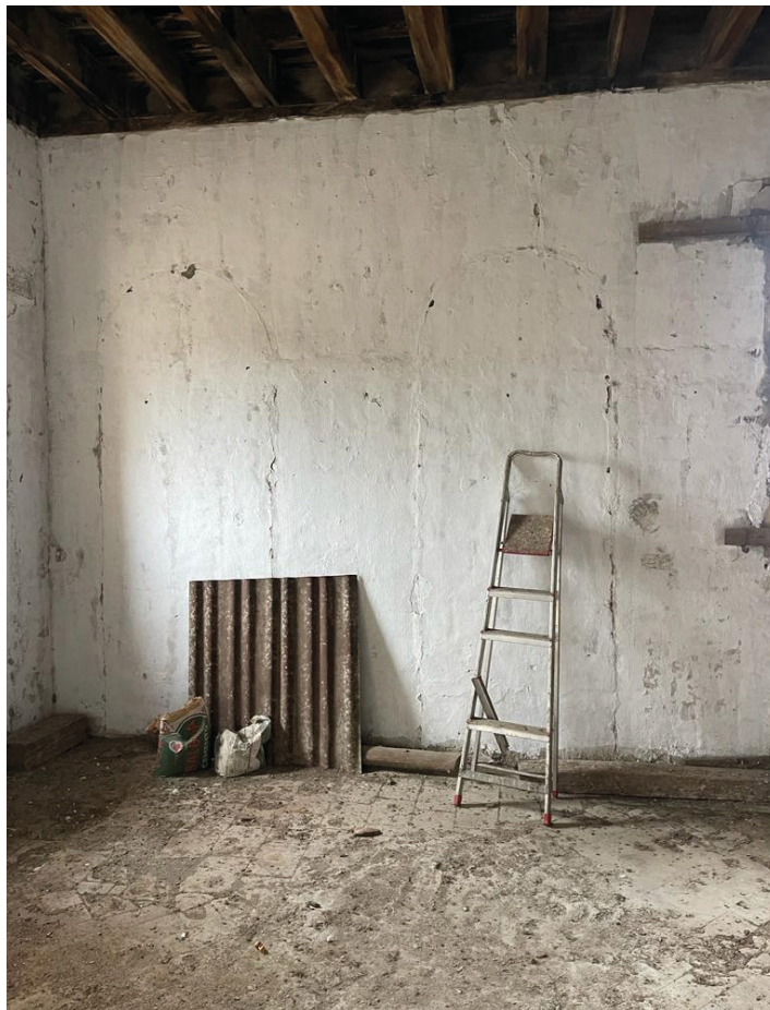
[Fig.63] Arcos tapiados en el Palacio del Conde de la Oliva. Elaboración propia.
