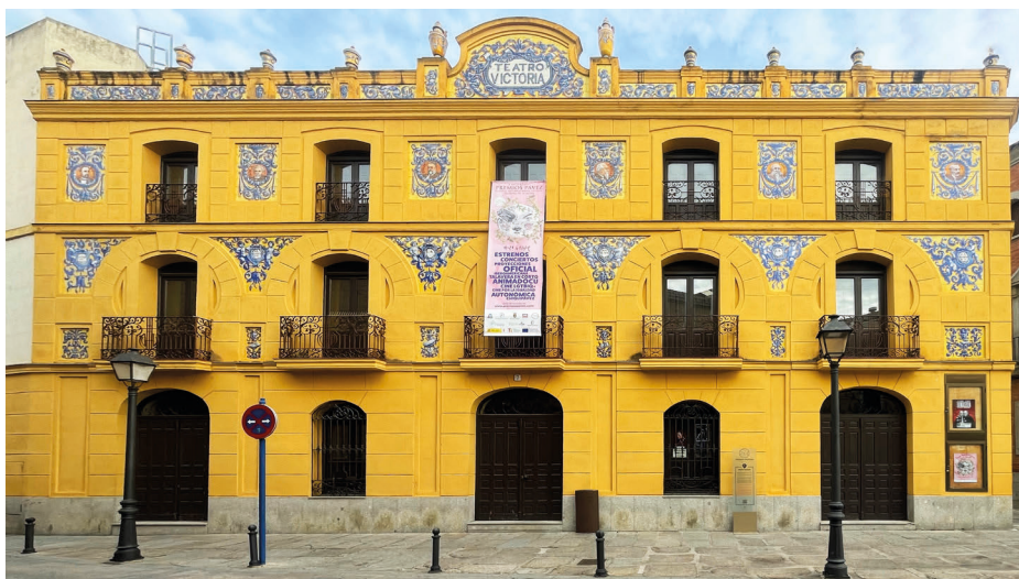
[Fig.55] Fotografía de la fachada del Teatro Victoria. Elaboración propia.
