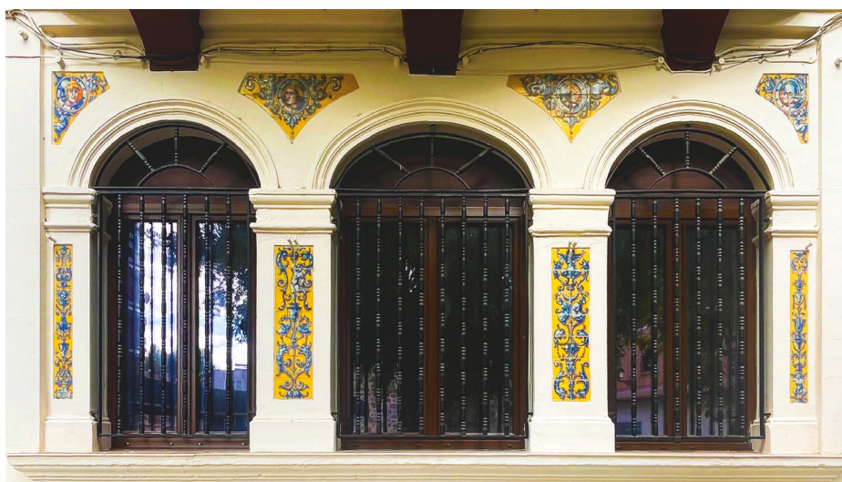
[Fig.76] Fachada del colegio Juan Ramón Jiménez. Elaboración propia.
