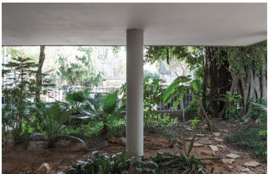
[Fig. 71] Imagen de edificio de planta baja libre con vegetación.
