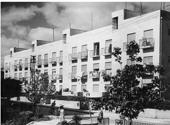
[Fig. 88] Viviendas para obreros, Arie Sharon, 1936.
