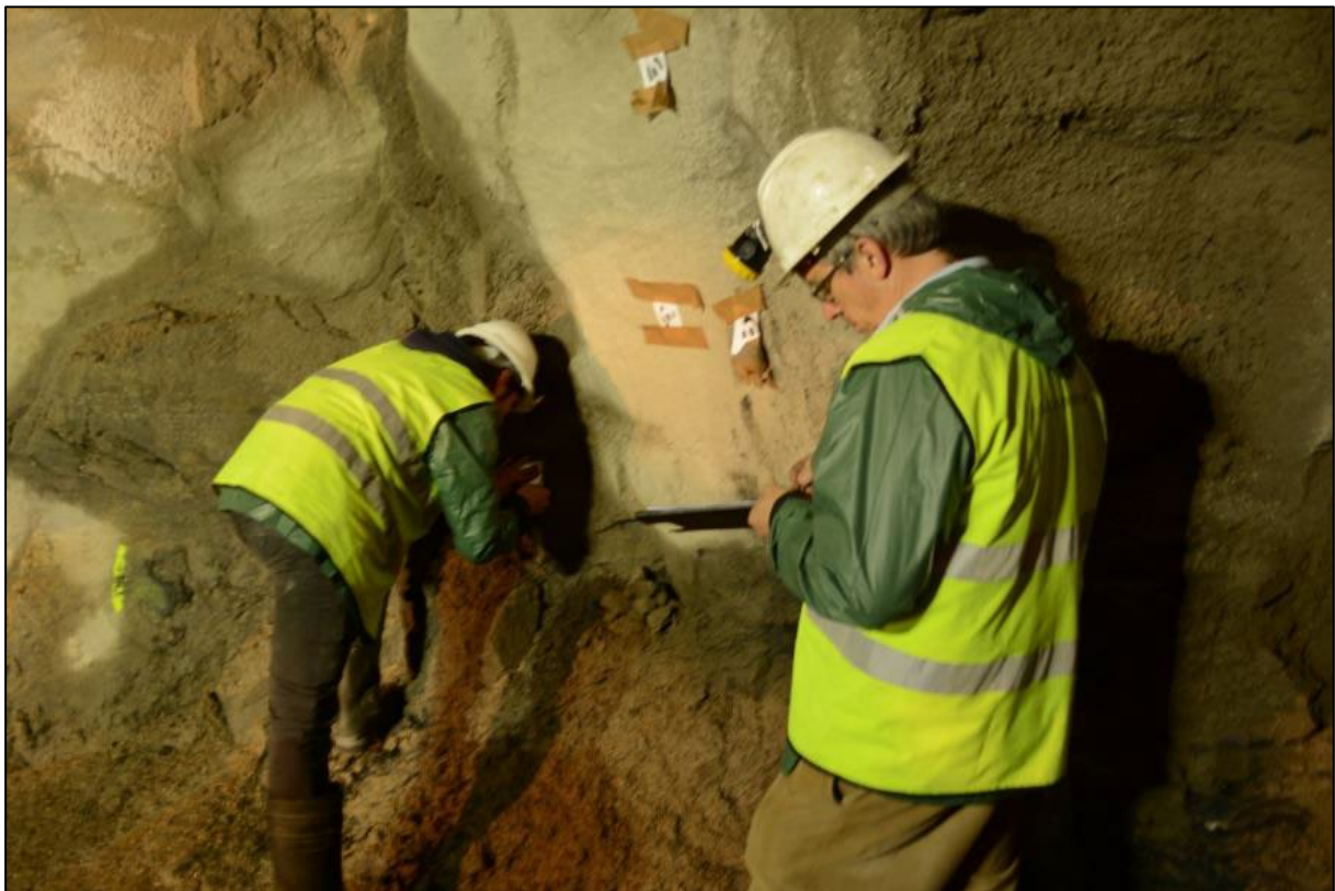
Figura 21. Caracterización manual de las familias de discontinuidades en el Túnel 2.
