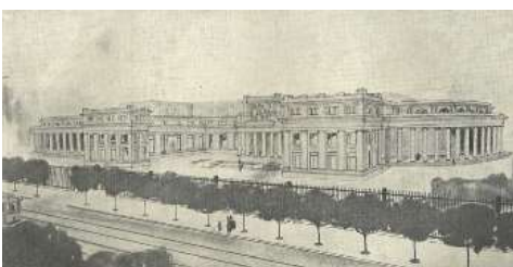
Fig.2. Tipo de Pabellón principal o de entrada número 1 del de distribución general. Javier de Luque.1931.
