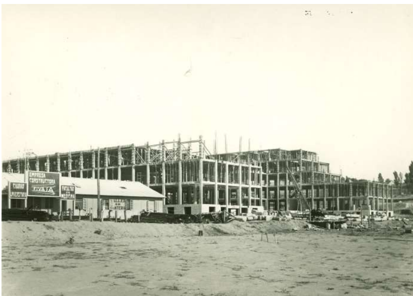
Fotografía de la construcción de la Facultad de Medicina AGUCM, D-1913. c.a.1932.
