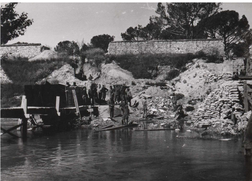
Frente de Madrid. Ciudad Universitaria. Pasarela y parapetos en la Ciudad Universitaria BNE. GC-CAJA/61/16/13. 19-05-1938.
