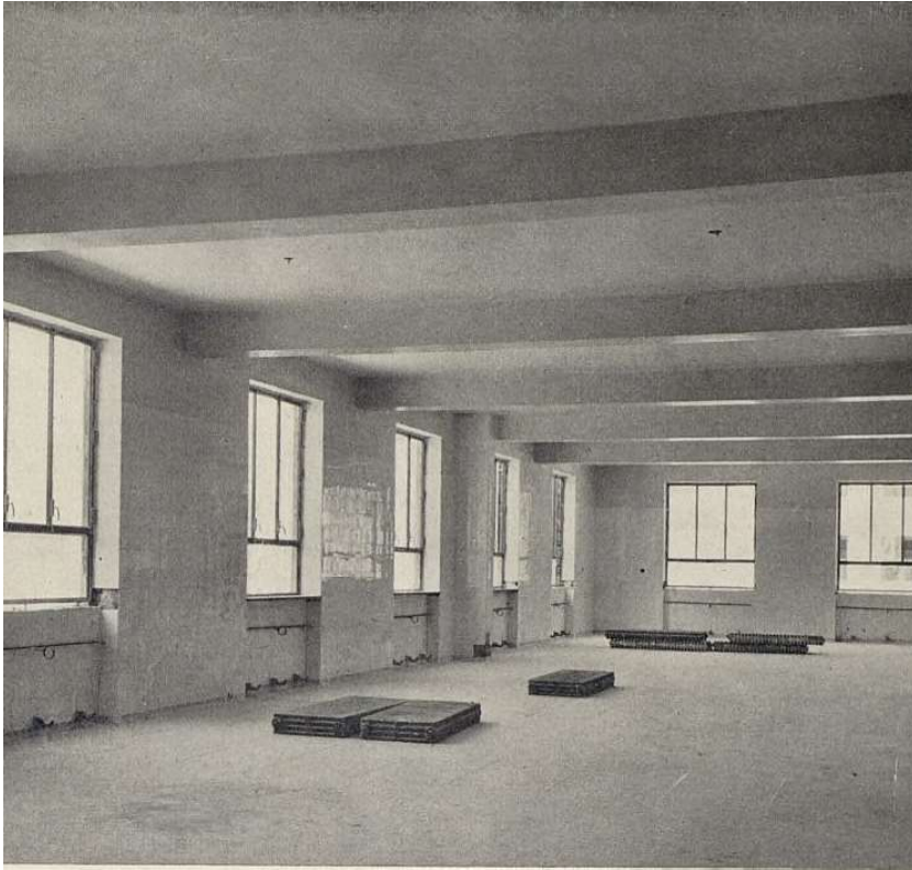
Facultad de Medicina. Ala de laboratorios con radiadores sin montar. Revista Nuevas Formas p.317. N°6. 1935.
