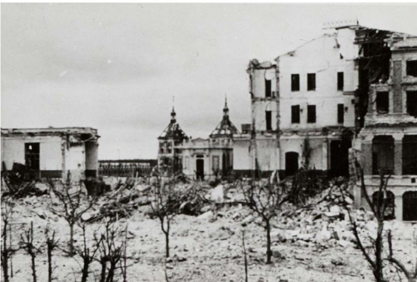
Efectos de los bombardeos en Madrid. Ciudad Universitaria. Efectos de la 2ª voladura de la Escuela de Ingenieros Agrónomos visto desde la Facultad de Odontología. BNE. GC-CARP/76/1/8. s.f.
