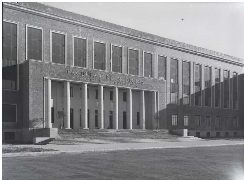
Fachada principal de la Escuela de Estomatología. [1940-1950]. Fotógrafo: Castellanos. AGUCM 183/16. ca.1945
