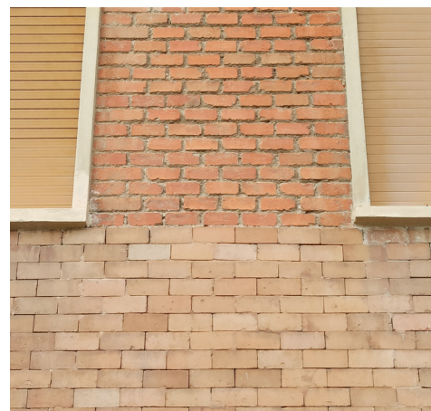
Fig. 16. Detalle de la unión entre el ladrillo apantillado de Andújar y el empleado para la reconstrucción. Facultad de Odontología Fotografía propia. 2021.
