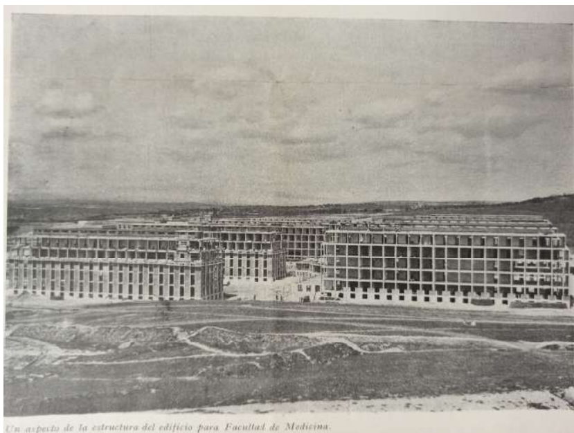
Aspecto de la estructura del edificio para Facultad de Medicina. AGUCM, D-1712. ca. 1932. C9.Fig. 12.
