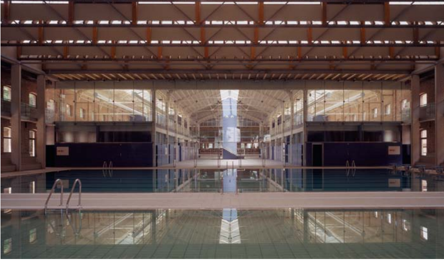
Rehabilitación para polideportivo de Daoiz y Velarde
