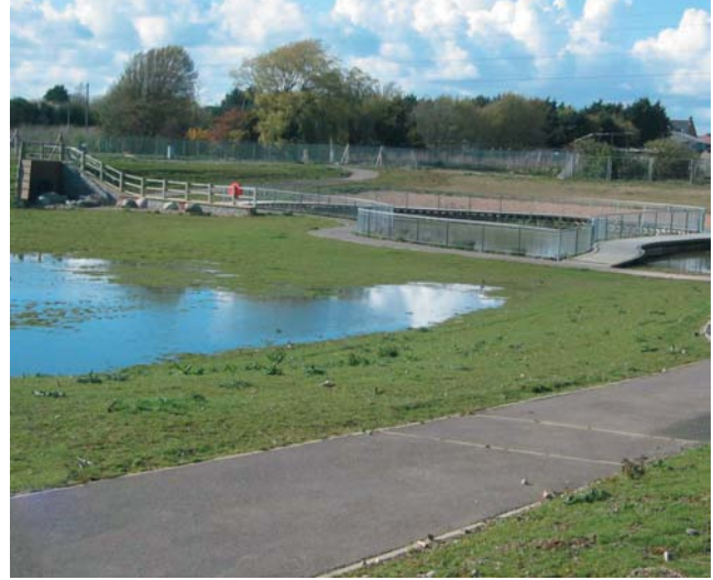
Depósito de infiltración.
