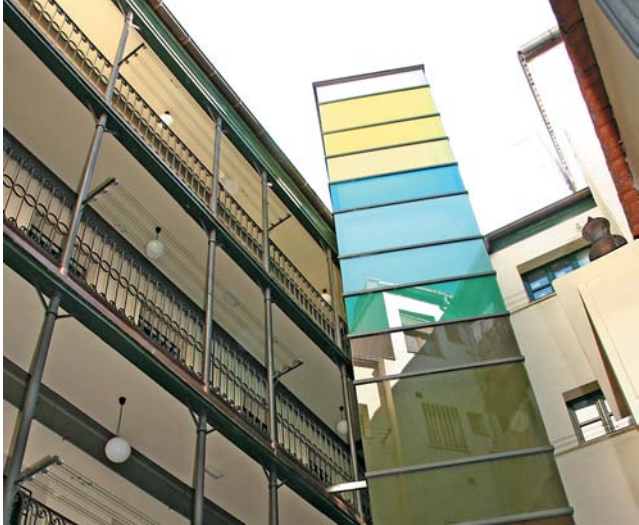
Rehabilitación en calle Provisiones
