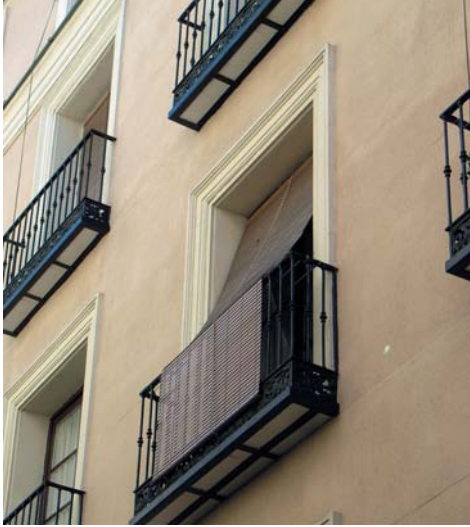
Balcón con protección tradicional de hueco. Madrid
