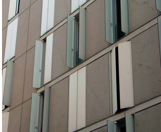
Balcón actual con contraventanas, Madrid
