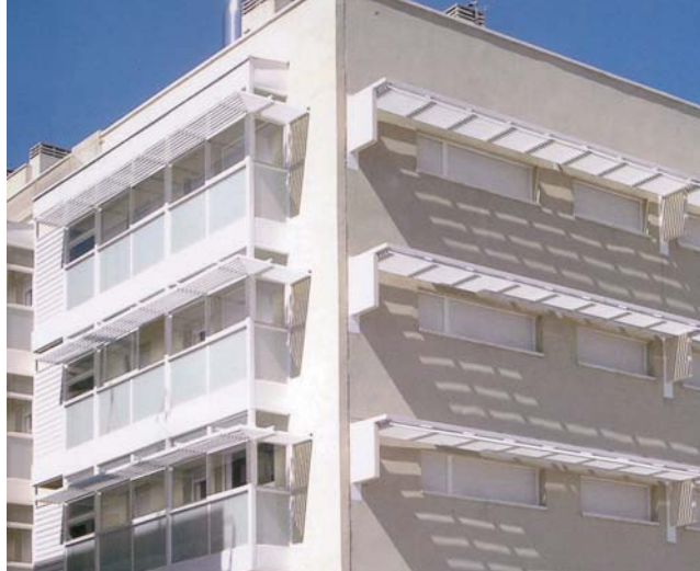
Elementos volados y protección de huecos en fachada
