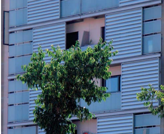
Balcón actual con protección solar exterior, Madrid
