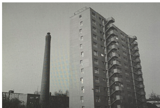
Figura 11. Chimenea de la Fábrica la Norah, Villaverde
