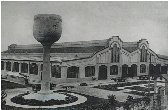
Figura 39. Depósito de agua conocido como La copa de Villaverde junto a los talleres de ferrocarril
