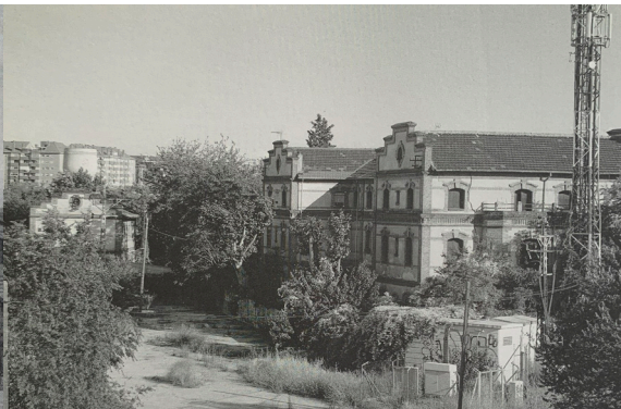
Figura 40. Estado actual de la antigua estación de tren de Villaverde
